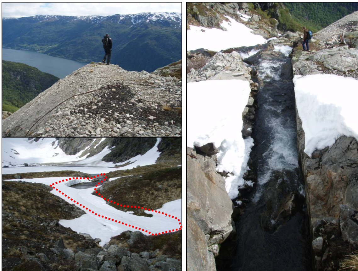
Figur 3 Øverst tv: Massedepoiet ligger ytterst på kanten mot Sørfjorden. Høyre: Utløpet av den sprengte avløpstunnelen fra Lausvatnet: Nederst tv: Det er gravd en ca. 80 m lang og 3-10 m dyp kanal frem til tunnelinnløpet.
