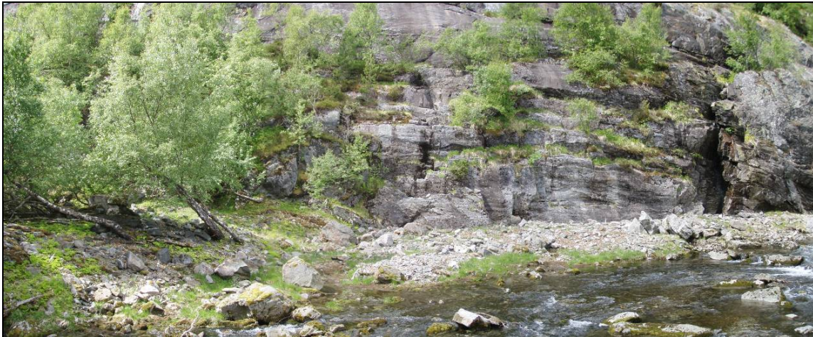
Figur 10 Område for tunnelpåhugg, Digraneselvi i forgrunnen.
