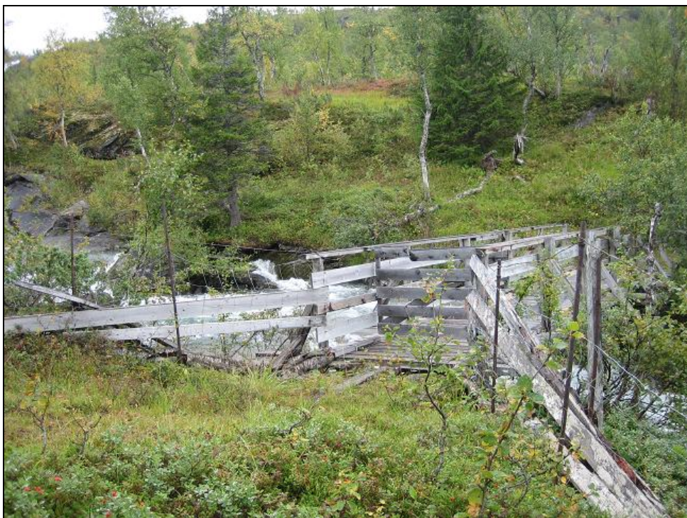
Foto 4. Elva er under høy vannføring et naturlig vandringshinder, brua er utstyrt med en grind for å hindre at sau skal kunne krysse elva.
