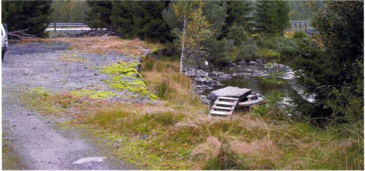
Figur 7, Stasjonsområde til høyre i bildet
