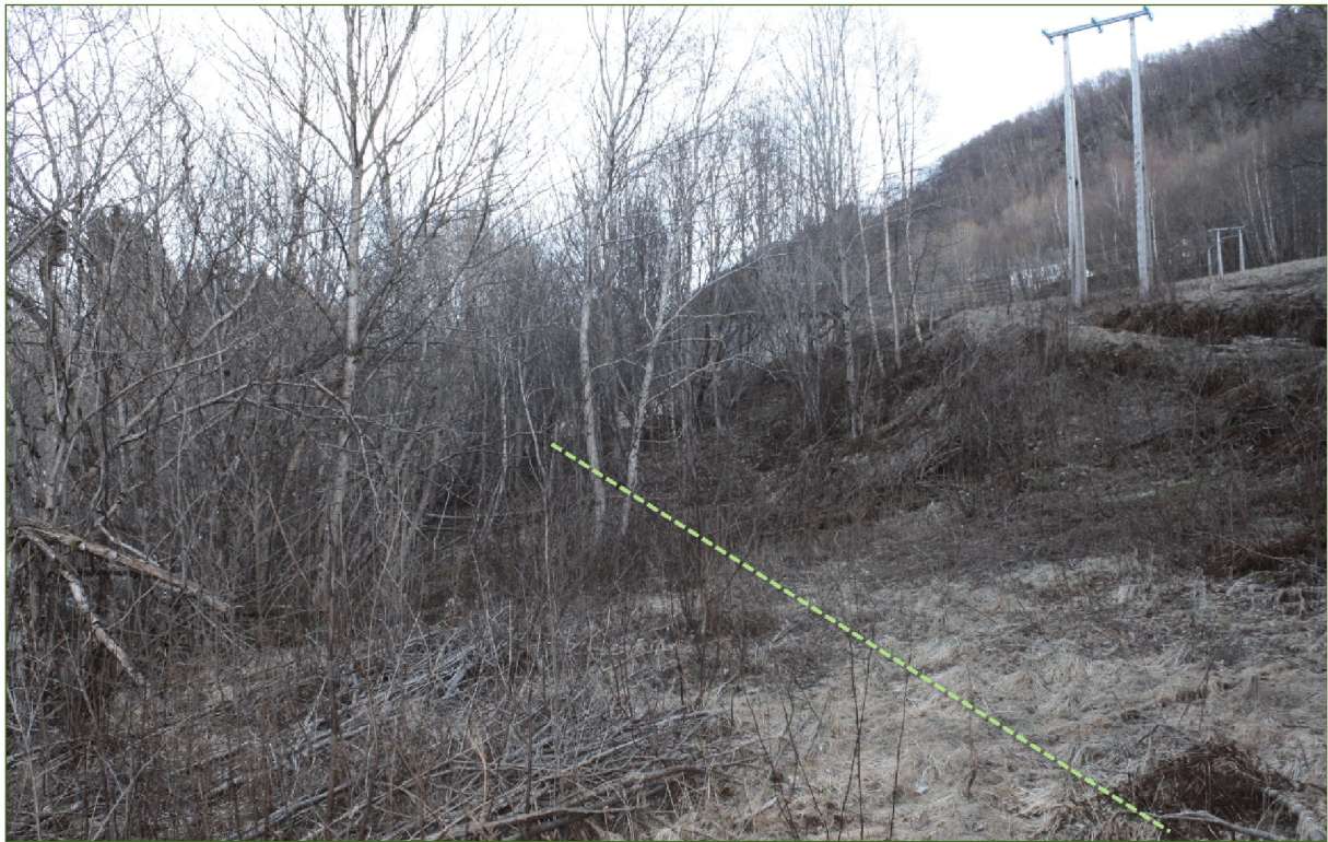
Foto 7 Røyrtrase ned mot kraftstasjon.
