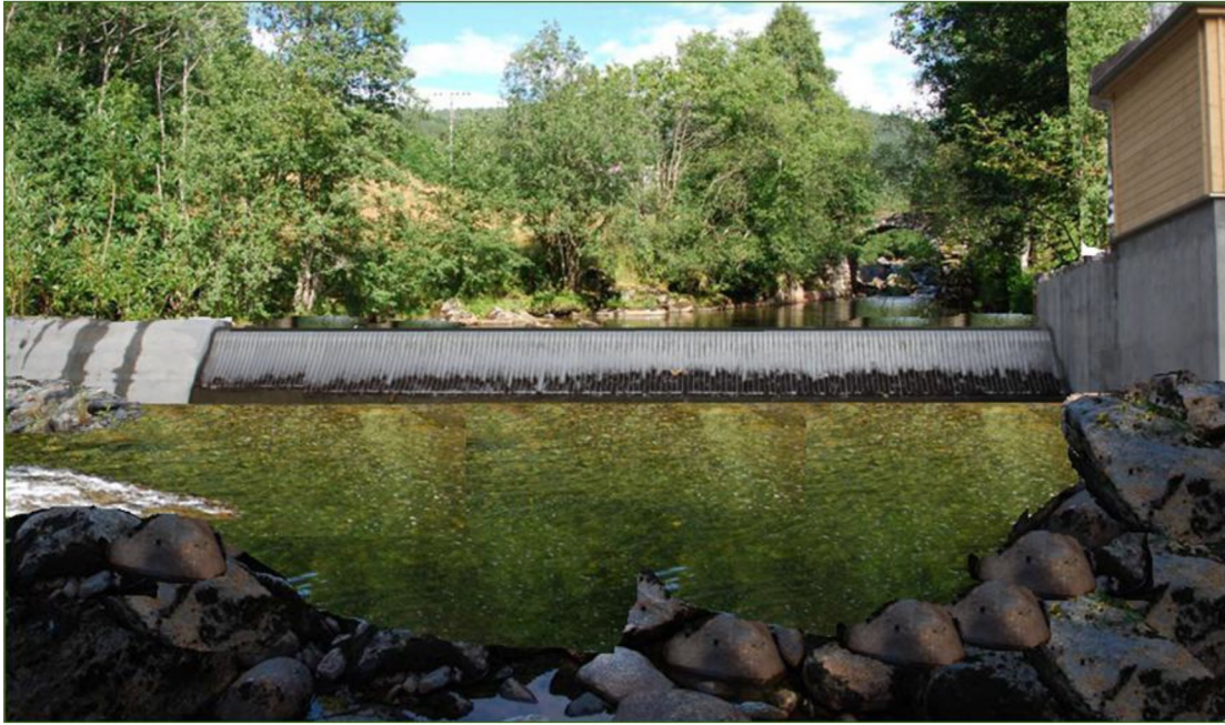
Fig. 2.2.4.6 Inntaksområdet med fotoillustrasjon av Coandainntak sett nedstrøms
