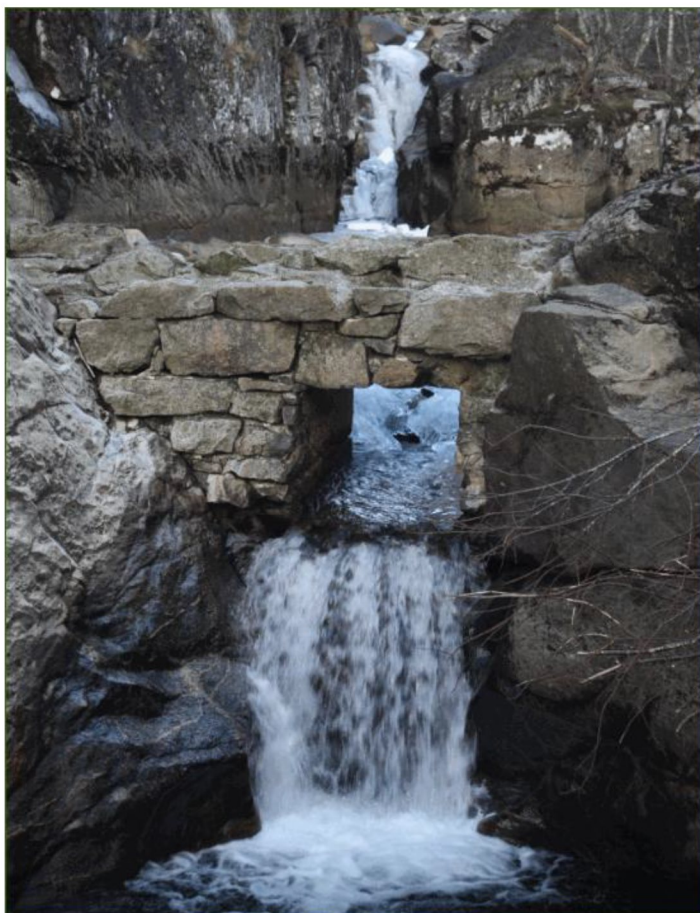
5. februar 2014. Vassføring om lag 200 l/s. Ved inntaket til det gamle kraftverket.
