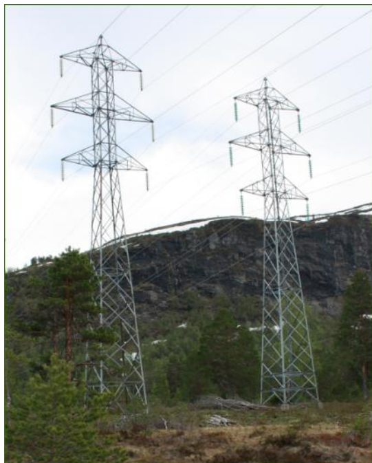
Figur 1.5.1 To masterekker med til saman fire 132 kV linjer kryssar Vaksvikbygda.
