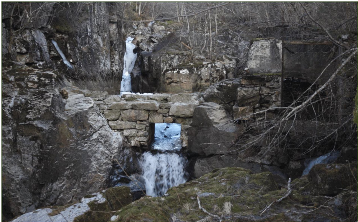
Foto 10 Restar av det gamle kraftverksinntaket.
