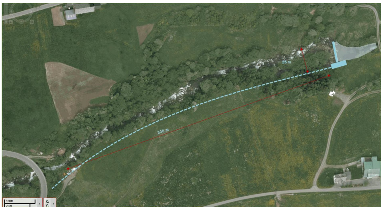
Figur 3.17.1 Foto viser elv mellom inntak og riksveg.
