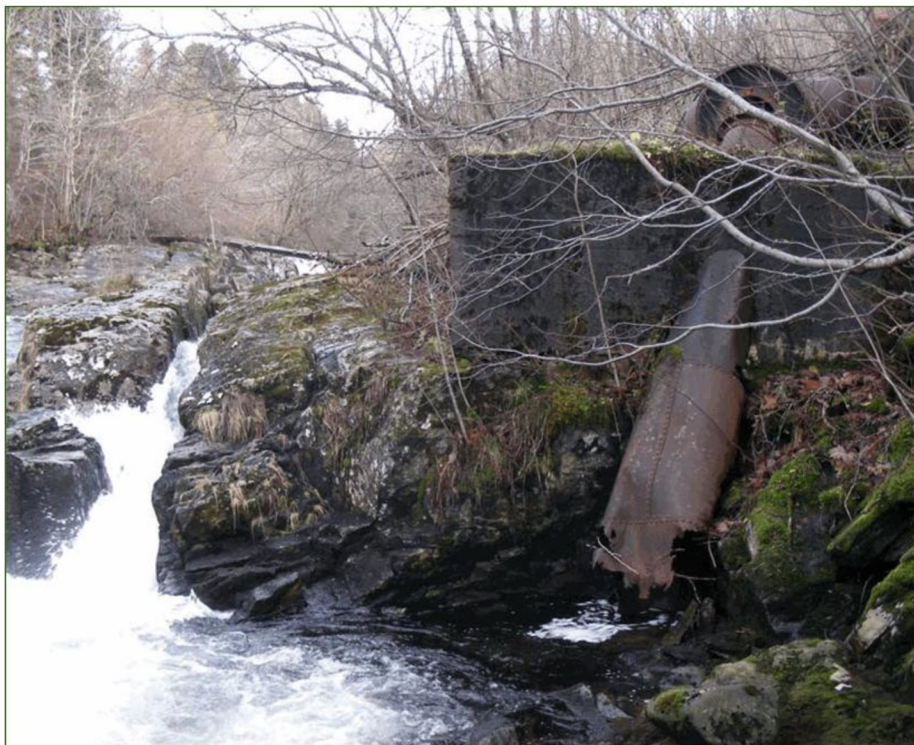
Figur 2.2.6.3 Foto av fundamentet til den gamle kraftstasjonen.
