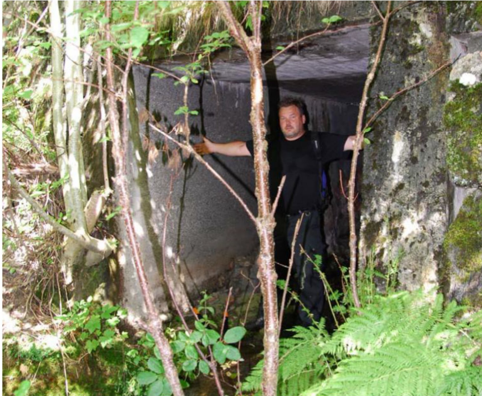
Foto 11 Opning i fundament under brua / riksvegen.
