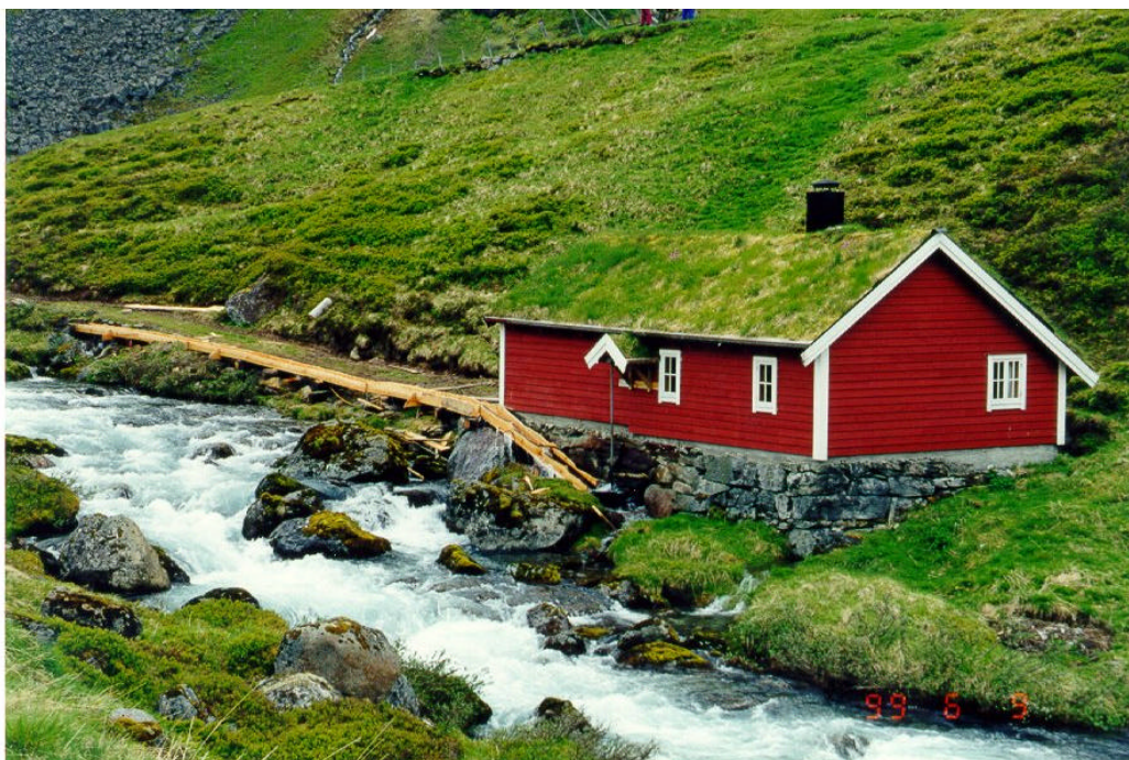
Bilde 2: Restaurert stølsmeieri på Nesstølen.
