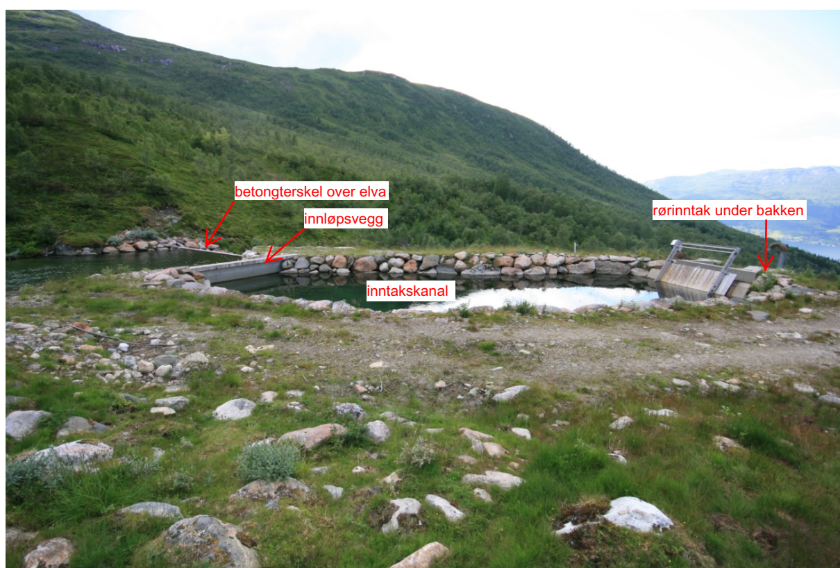
Tilsvarande inntak ved Bjørndalselva kraftverk. Inntakskanalen har bredde 7 m og lengde 28 m.
