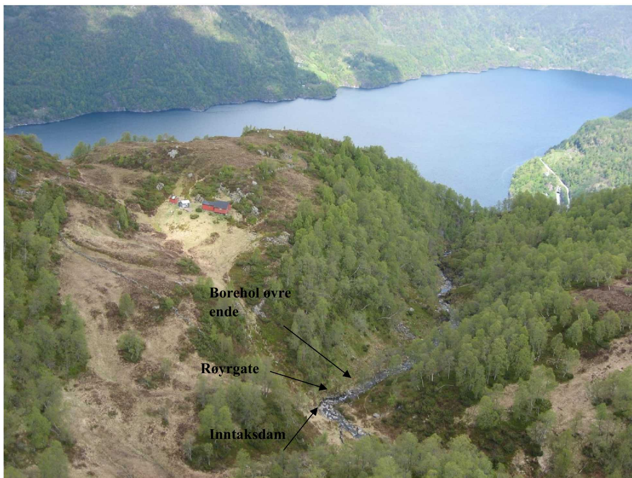
Figur 8 Oversikt inntaksdam og øvre røyrgate.
