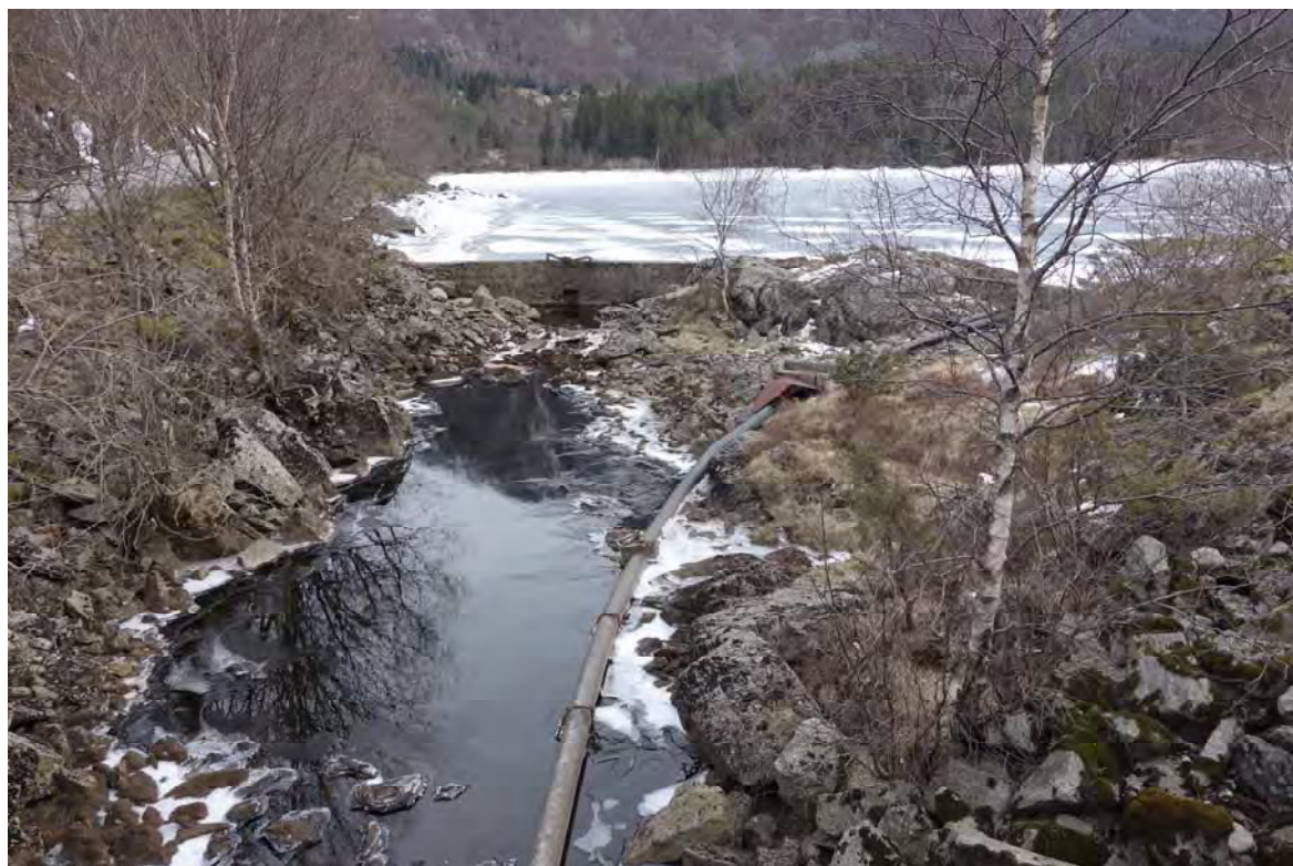
Eksisterende dam og rørledning fra utløpet av Storevatnet
