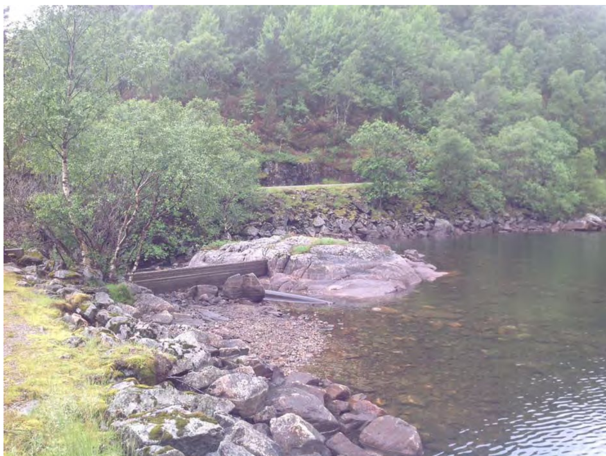
Like oppstrøms dam ved Storevatnet, røret til settefiskanlegget går rett ut i vannet.
