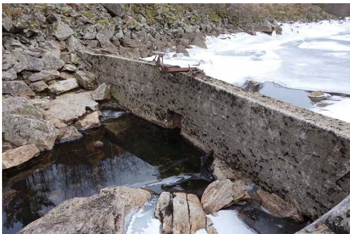
Eksisterende dam ved Storevatnet
