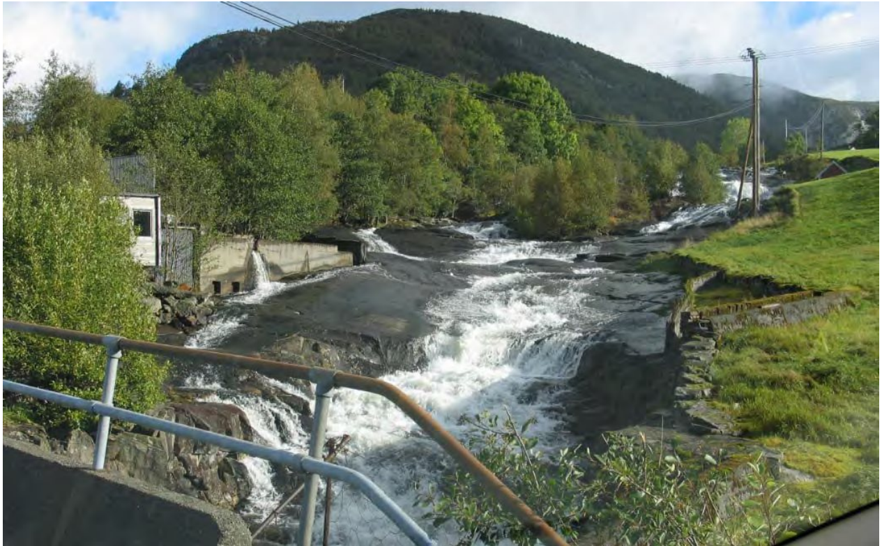
Dato: 18. september 2007. Vannføring 1,1 m 3 /s
