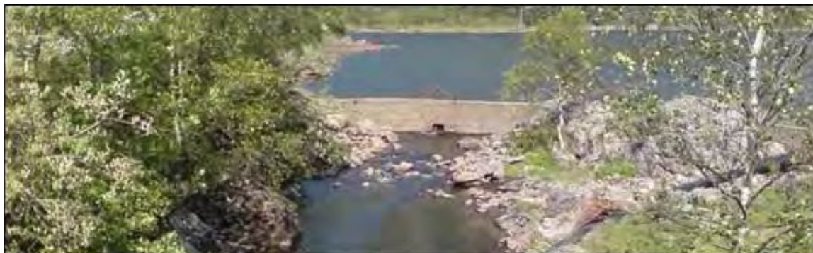
Figur 2-4 Eksisterende inntaksdam ved Storevatnet
