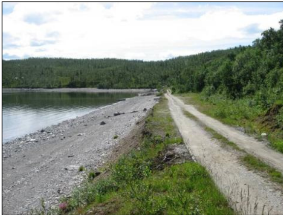
07. Kraftstasjonsområde ved Røssvatnet. Foto: MiljøKraft Nordland AS.
