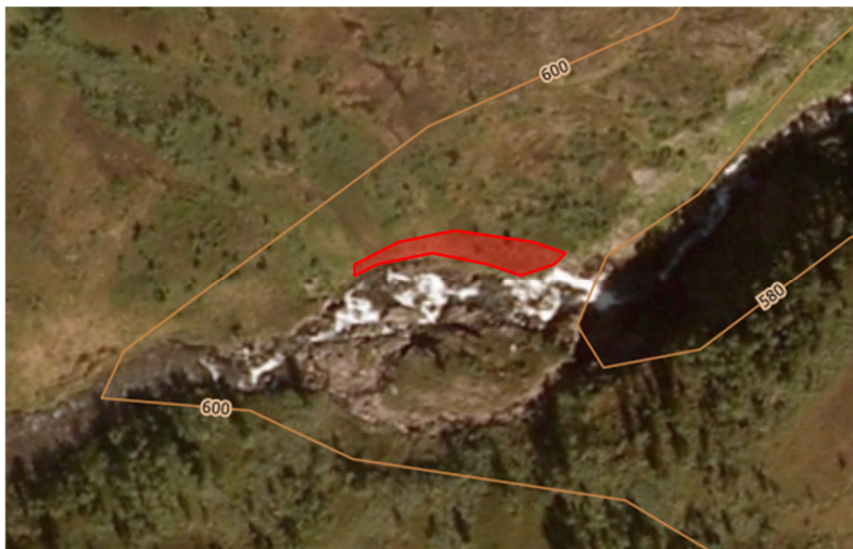
Figur 3-9. Fossesprøytsone ved kote 590.
