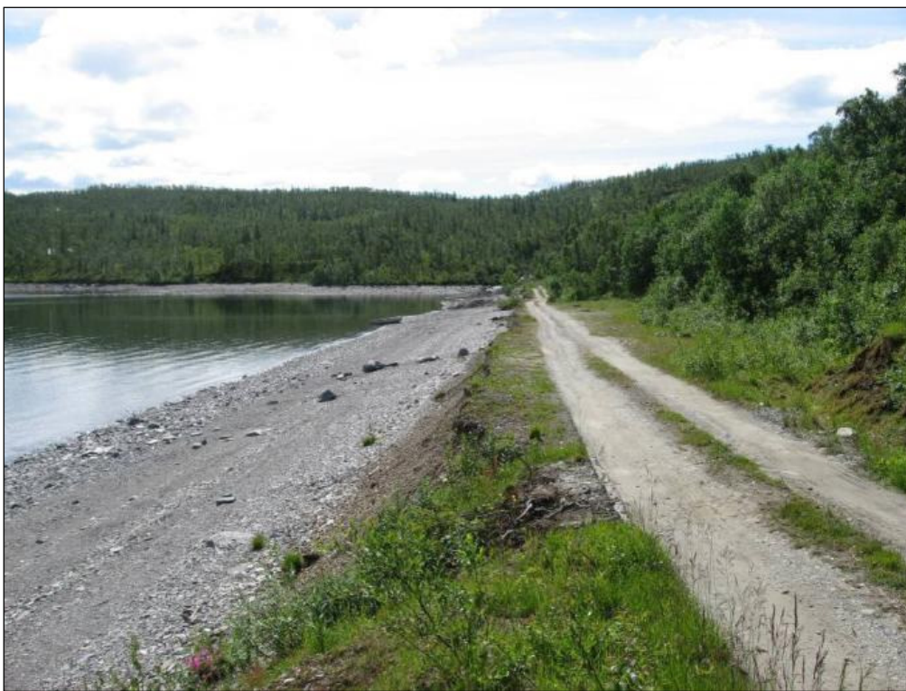
Figur 2-17. Kraftstasjonsområde ved Røssvatnet. Foto: MiljøKraft Nordland AS.
