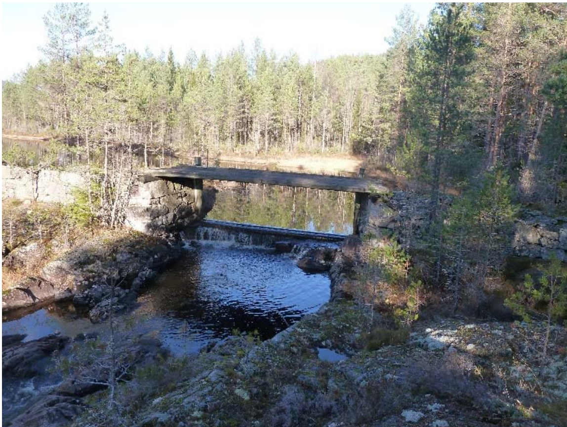
Breitjerndammen/Pruppdammen, 29.10.2014, vannføring 0,18 m 3 /s fra Samsjøen
