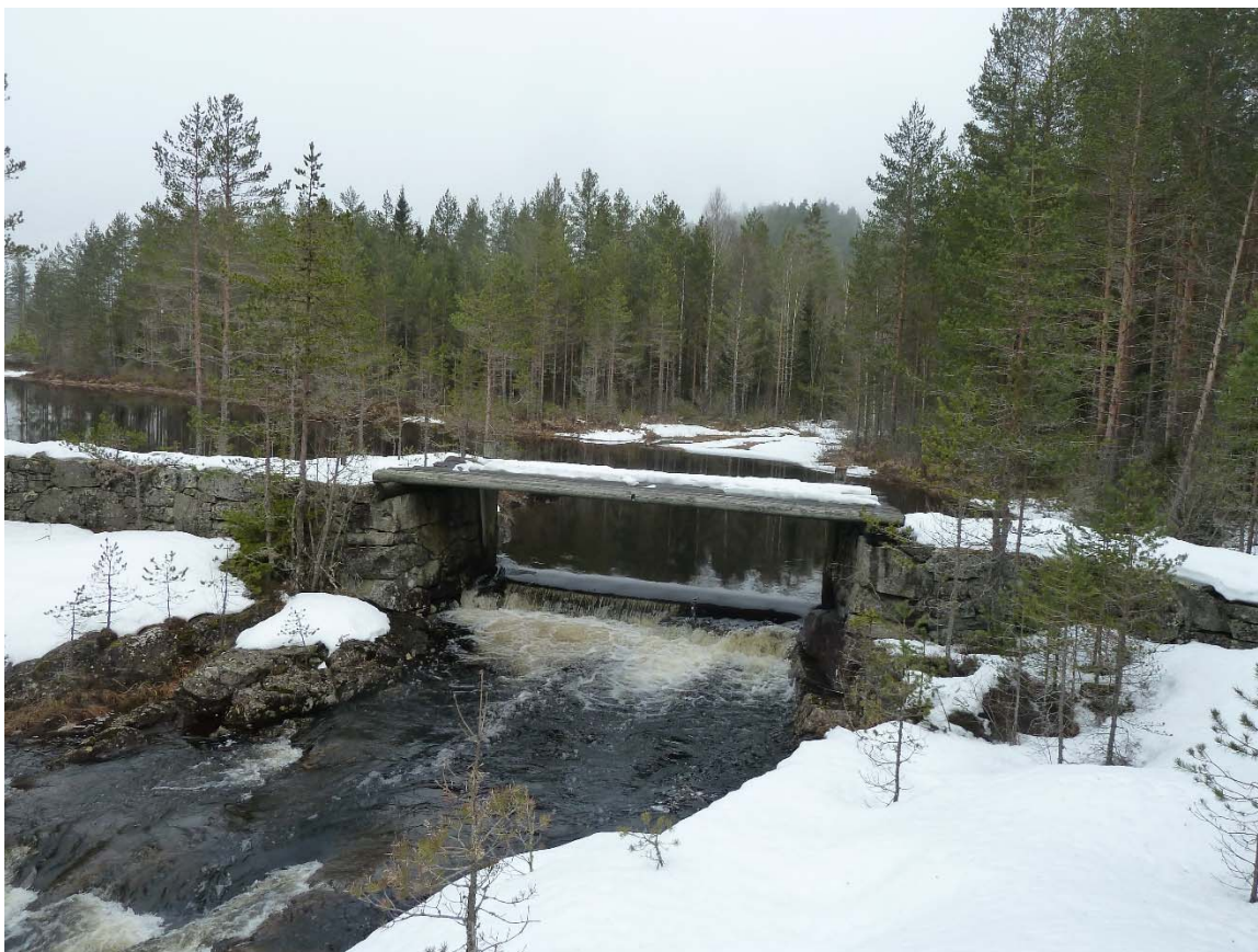
Breitjerndammen/Pruppdammen, 19.03.2015, vannføring 1,0 m 3 /s fra Samsjøen
