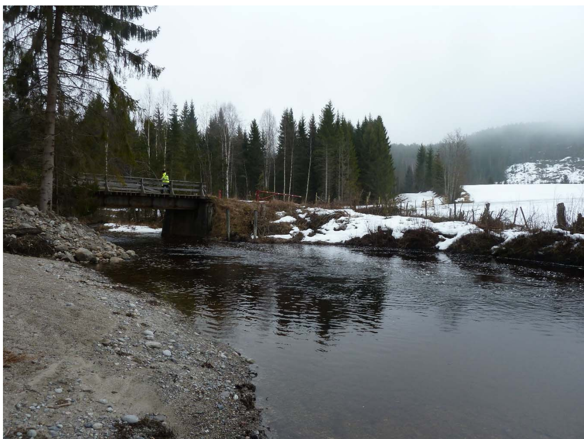
(4) Tverrbekken bru, 19.03.2015, vannføring 1,0 m 3 /s fra Samsjøen
