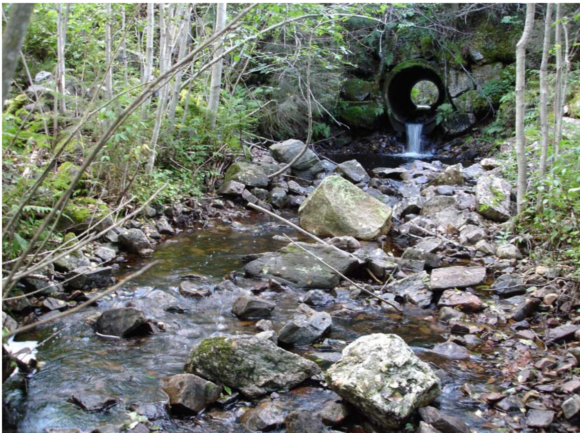
Bilde 1. Kulvert i Dalbekken ved Vestre Bjonevatn. Foto: Espen Lund.
