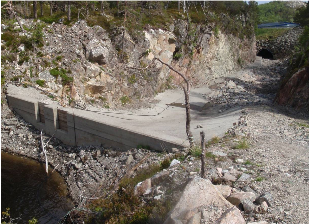
Figur 7: Demningen ved utløpet av Laksåvatnet.
