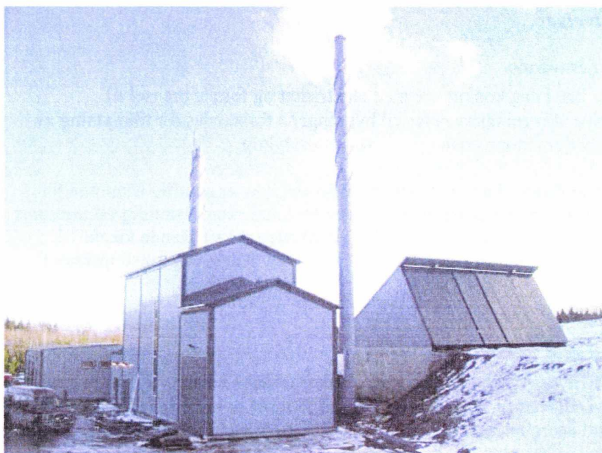
Figur 1 Bilde av Loviisa fjernvarmeanlegg (7MW) i Finland. (Kilde: LAKA eldingsteknik)
