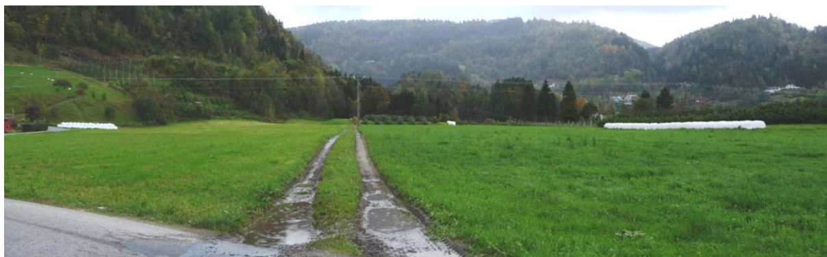
Adkomstveg over dyrket mark på Mo følger eksisterende landbruksveg. Permanent veg her vil ha innvirkning på kulturmiljøet på Mo.
