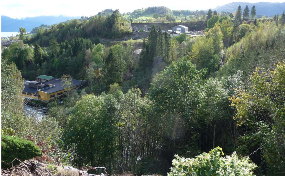
Utløpsområdet og adkomstveg frem til utløp i elva nedenfor industriområdet.
