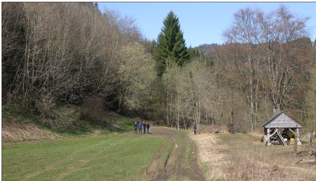
Figur 10. Jordbruksareal og traktorveg nedenfor planlagt tunnelpåhugg.
