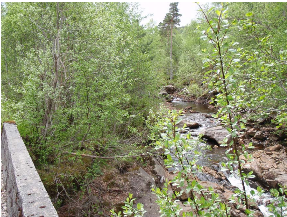
Første del av rørtrase etter inntak ned mot bro over Hennaelva
