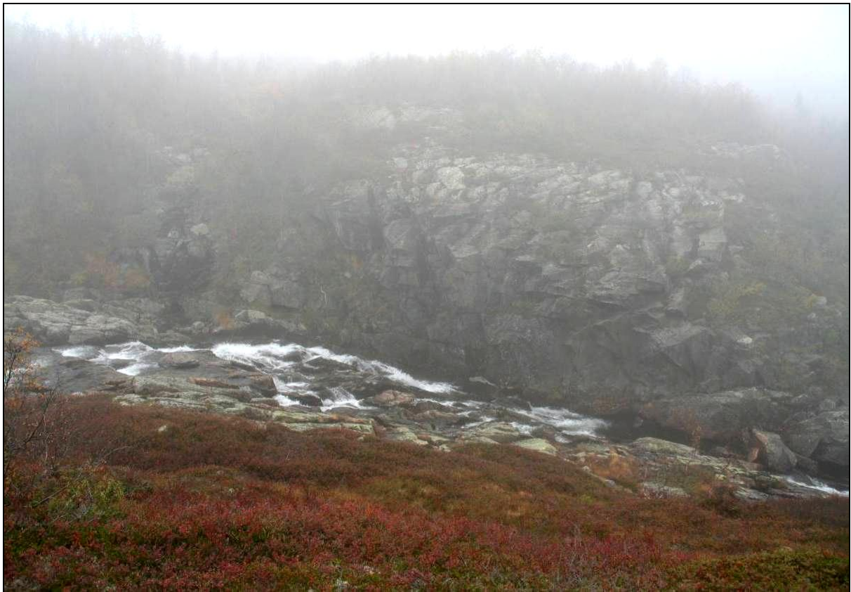
Figur 4. Inntaksområdet for Gjerdøla kraftverk ligger på kote 895. Foto: Ole Kristian Spikkeland.
