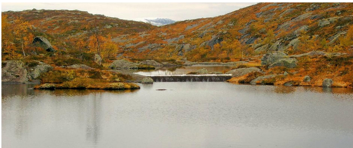
Bilde 2. Fotomontasje av sperredam Brekkevatnet (sett oppstrøms dam, mot utløp av Teigevatnet)
