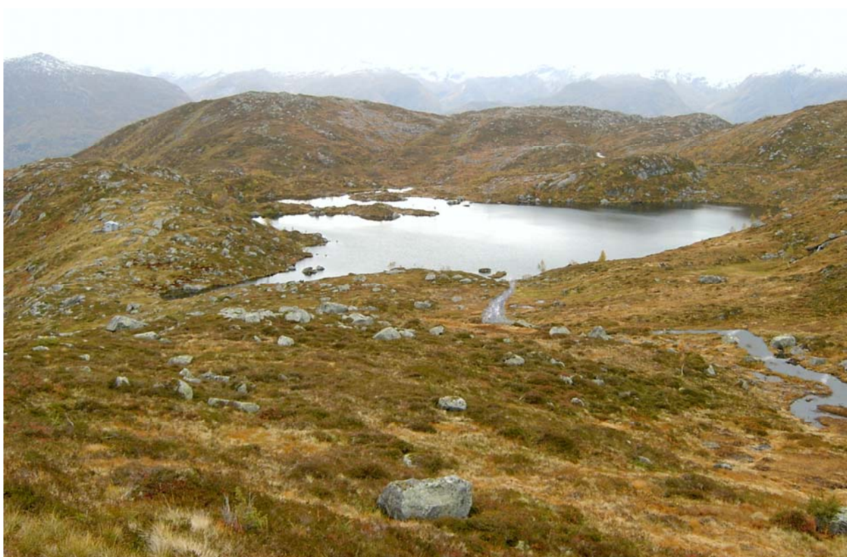
Bilde nr. 2 Nytt bekkeinnløp plastra/kanal til Brekkevatn
