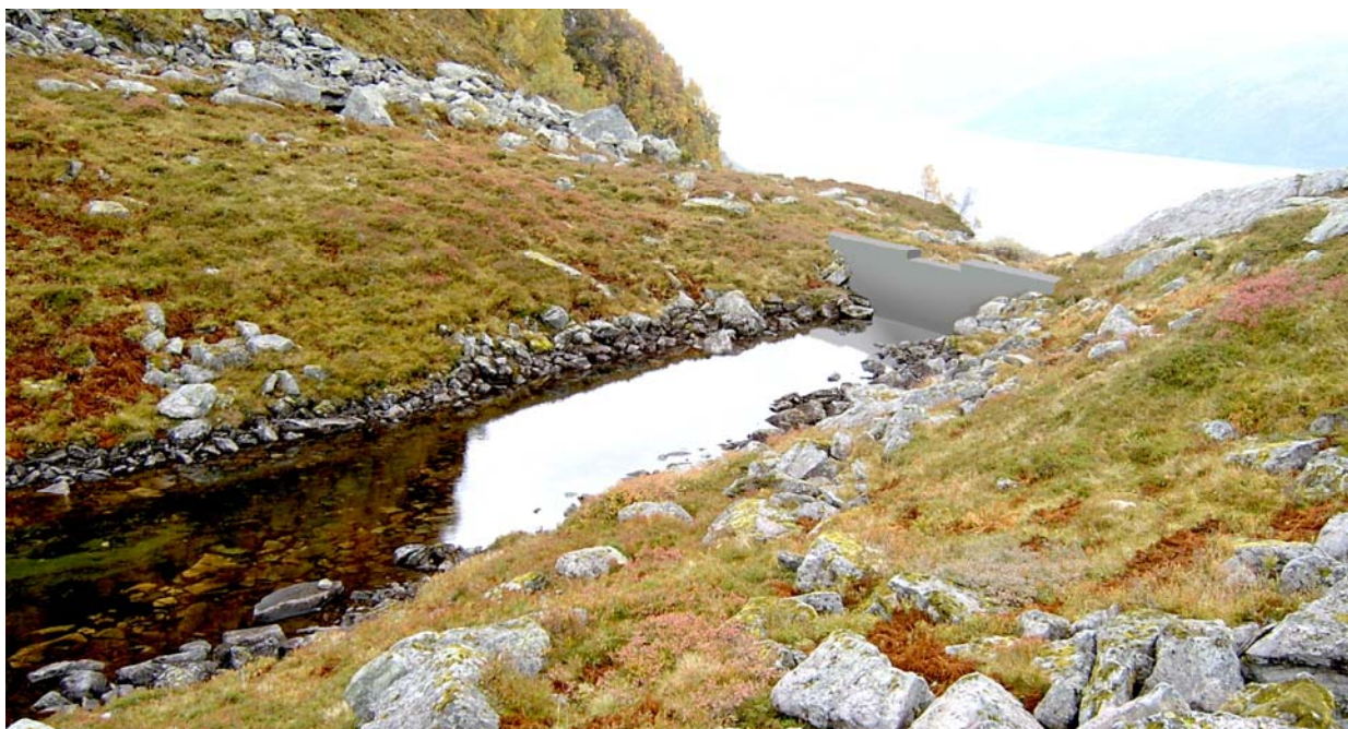
Bilde nr. 3 Bekkeinntak Brekkelvi kt. 730
