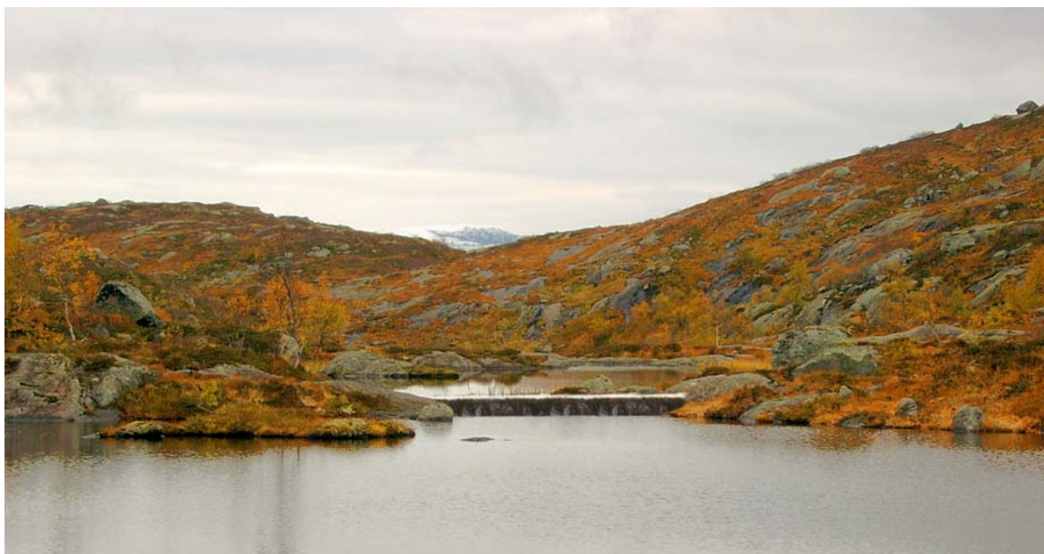
Bilde nr. 1 Sperredam ved utløp Brekkevatnet
