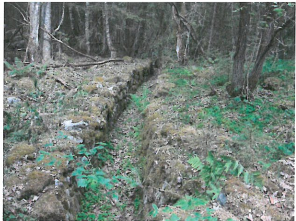
Bildene 7 og 8 over viser restene av et gammelt kraftverk, med gammel utløpskanal med utløp kote 187 noen hundre meter oppstrøms planlagt utløp for ny kraftstasjon.
