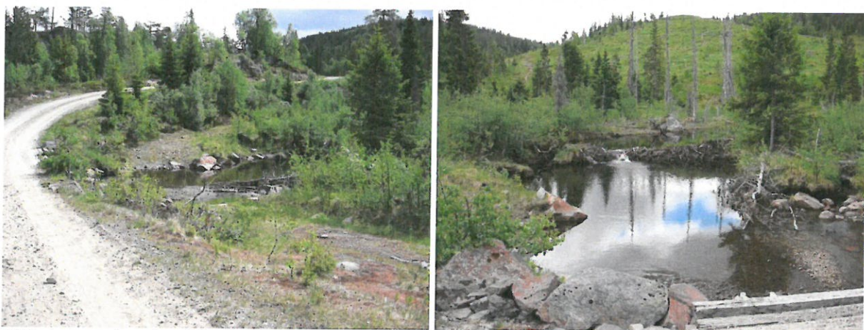
Bildene over viser skogsbilveien som krysser elva ved kote 640, rett oppstrøms planlagt inntak. Fotos: Ole Roer
