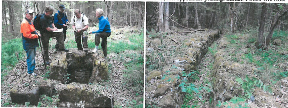
Bildene over viser restene av et gammelt kraftverk, med gammel utløpskanal med utløp kote 187 noen hundre meter oppstrøms planlagt utløp for ny kraftstasjon. Fotos: Ole Roer
