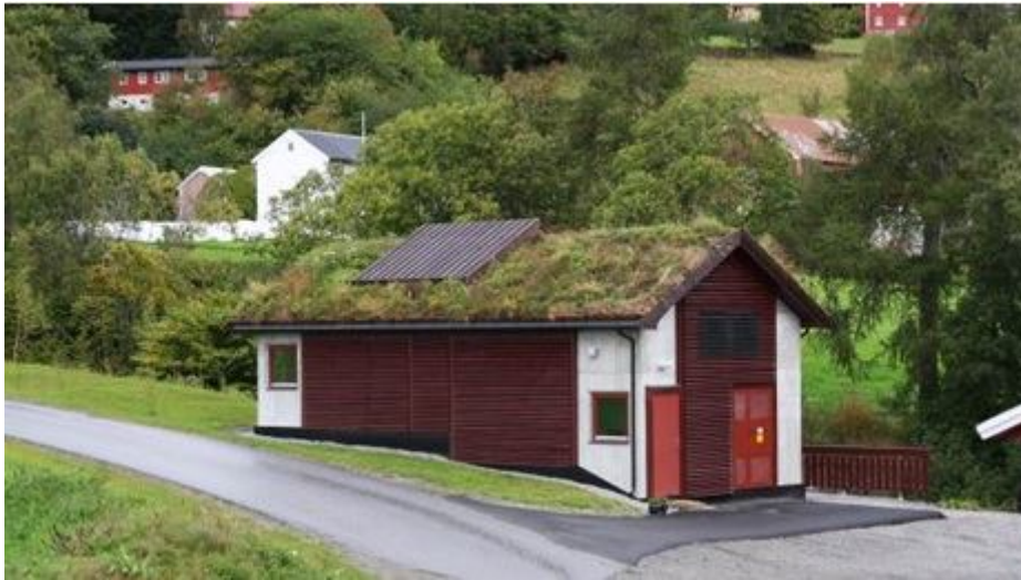
Bilde 3: Kraftstasjonsbygg lik det som er bygget i bl.a. Gyl kraftverk.
