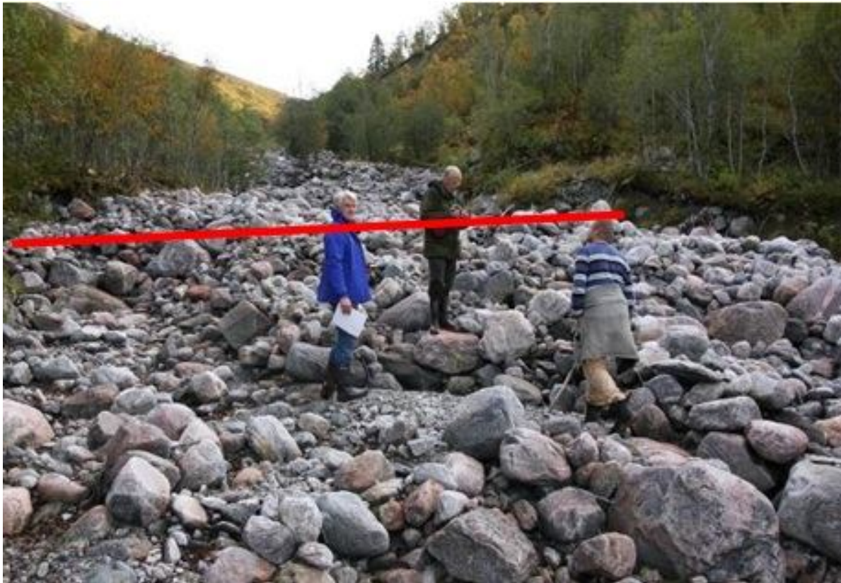
Bilde 1: Inntak kote 308. Terskel ved rød strek. Inntakskum til venstre for elveleiet.
