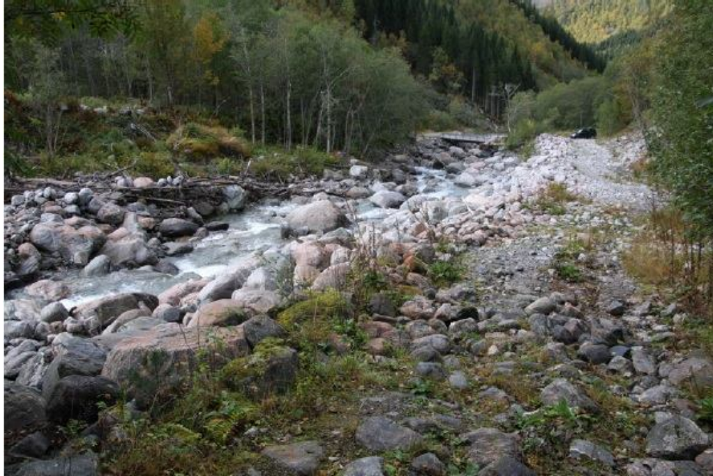
Bilde 2. Driftsvannrøret legges mellom veien og lifoten.
