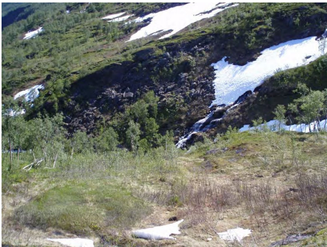
Foto 11 I dette området kommer overføringstraseen fra Littj Tverråga ned og krysser elven før den kobles sammen med røret fra Kvannelva.
