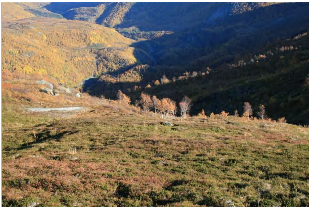
Figur 13. Øvre del av rørgatetrase i Kvannelva (venstre side).
