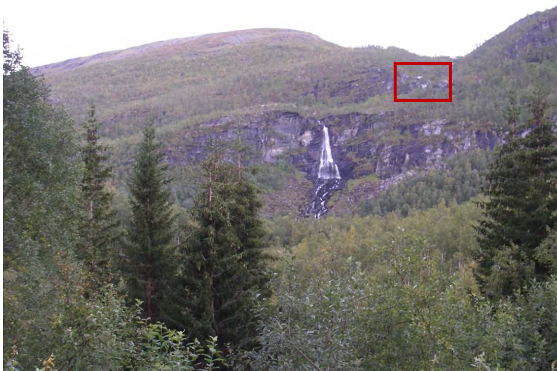
Figur 5. Littj Tverråga sett fra RV 830. 7. september 2010. Vannføring beregnet til 350 l/s. Innrammet er et fosseparti oppstrøms, også vist i de to neste fotoene.
