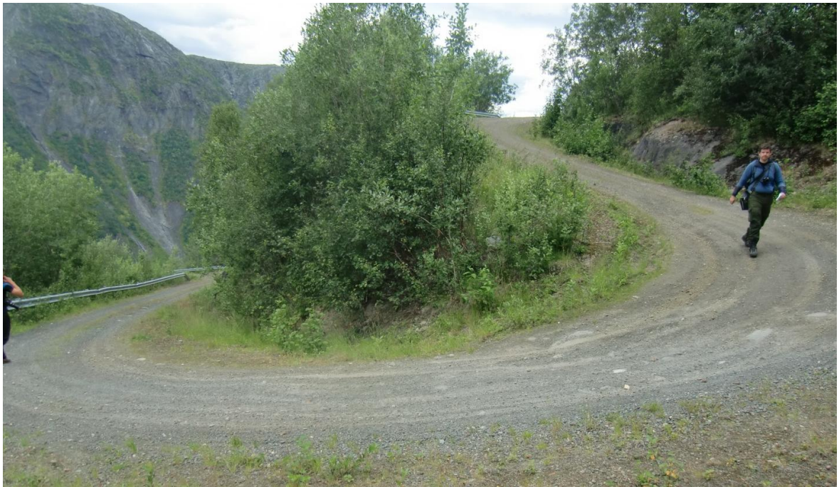
Figur 6: Eksempel fra eksisterende vei; slike svinger trenger betydelig oppgradering hva gjelder kurvatur og stigning
