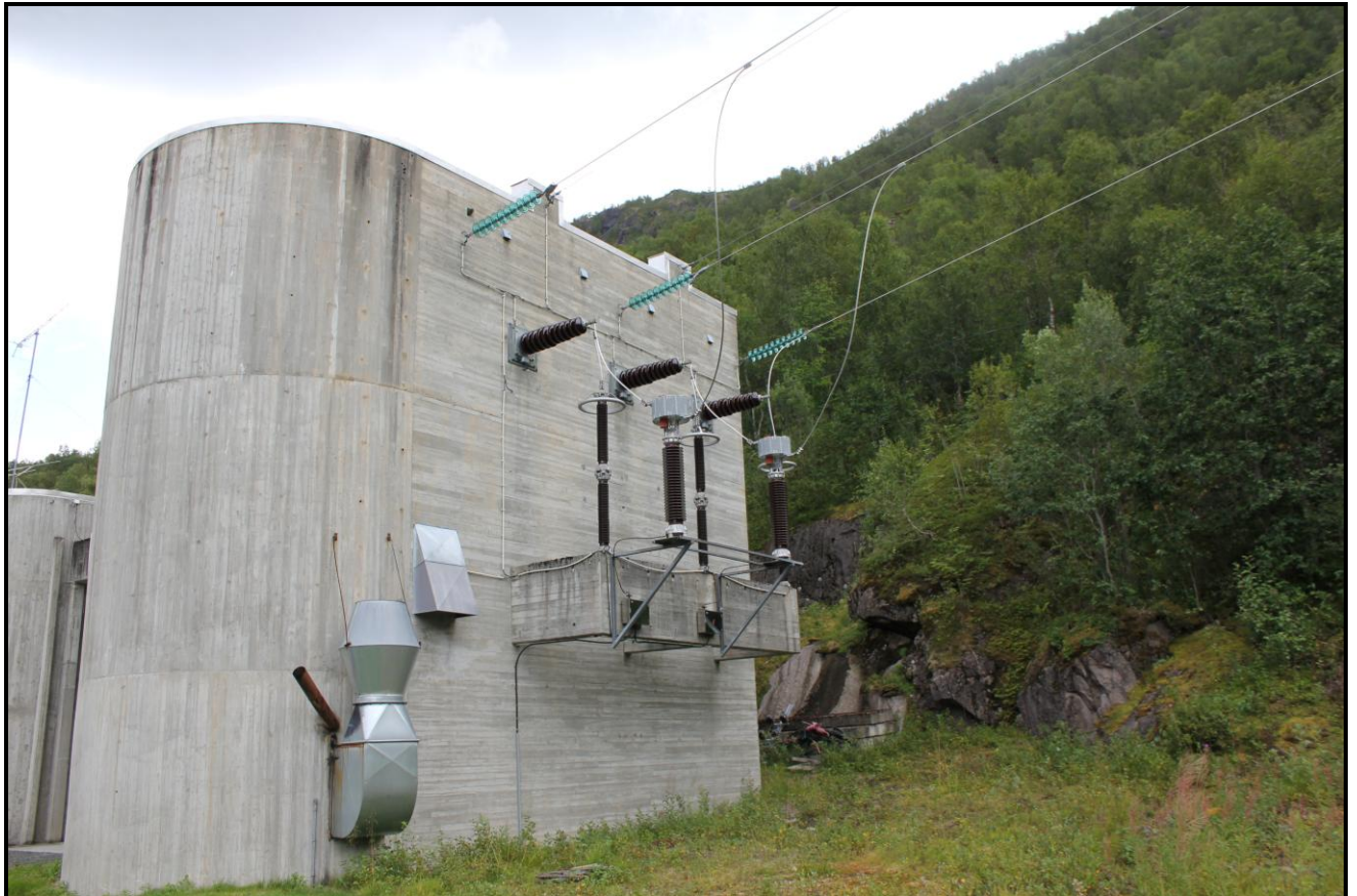
Figur 10. Sørfjord 1 kraftverk. Innstrek av eksisterende 132 kV ledning mot Kjøpsvik på vegg.
