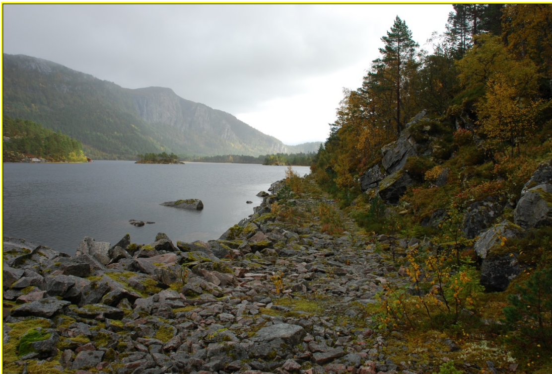
Figur 7: Eksisterende traktorvei langs Melvatnet som planlegges opprustet
