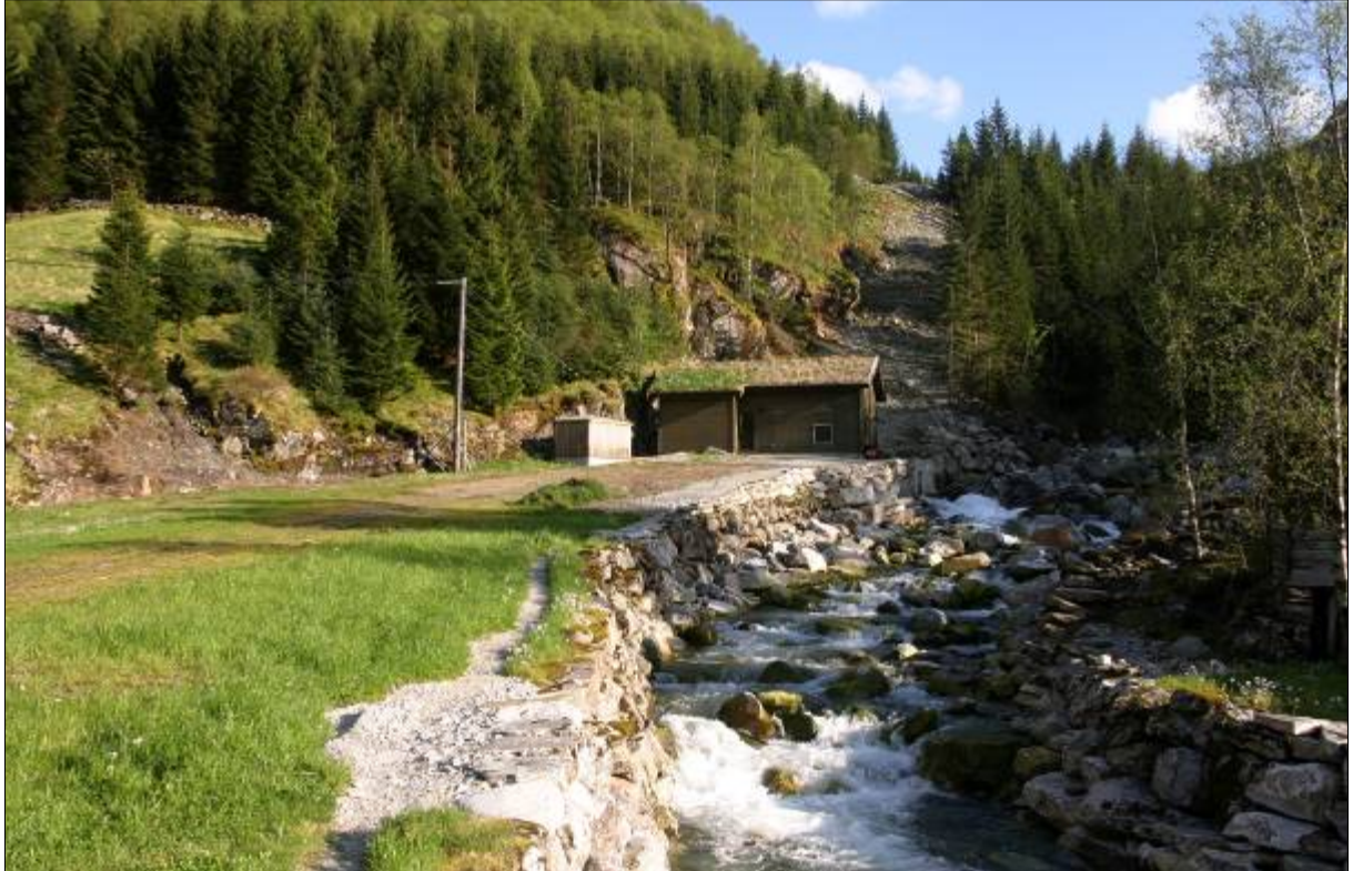
Figur 19. Eksempel på kraftstasjonsbygning med god arkitektonisk utforming og materialbruk tilpasset omgivelsene. Etter hvert som rørgatetraseen revegeteres vil synligheten av disse inngrepene være begrenset.
