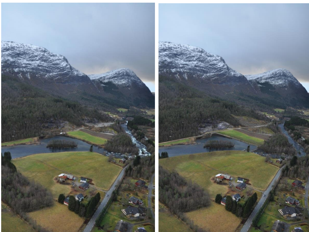
Figur 2. Inntaksområdet før (venstre) og etter (høyre) utbygging.
