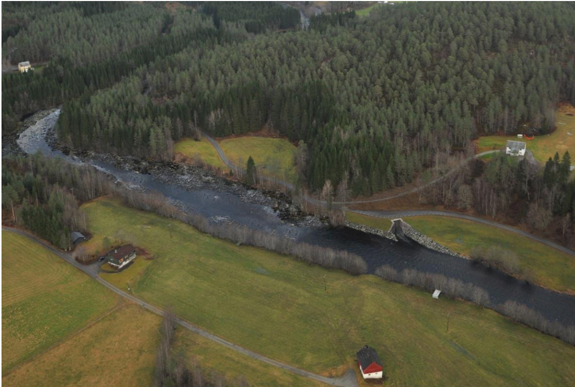
Figur 11. Utløpet ved Reinene. Utløpet er prosjektert med dykket utløp, slik at vannføringen ut vil bli oppbremset av motstanden til vannmassene i elva.
