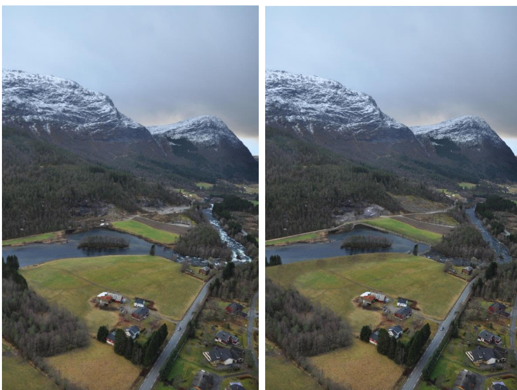
Figur 2-2. Inntaksområdet før (venstre) og etter (høyre) utbygging.
