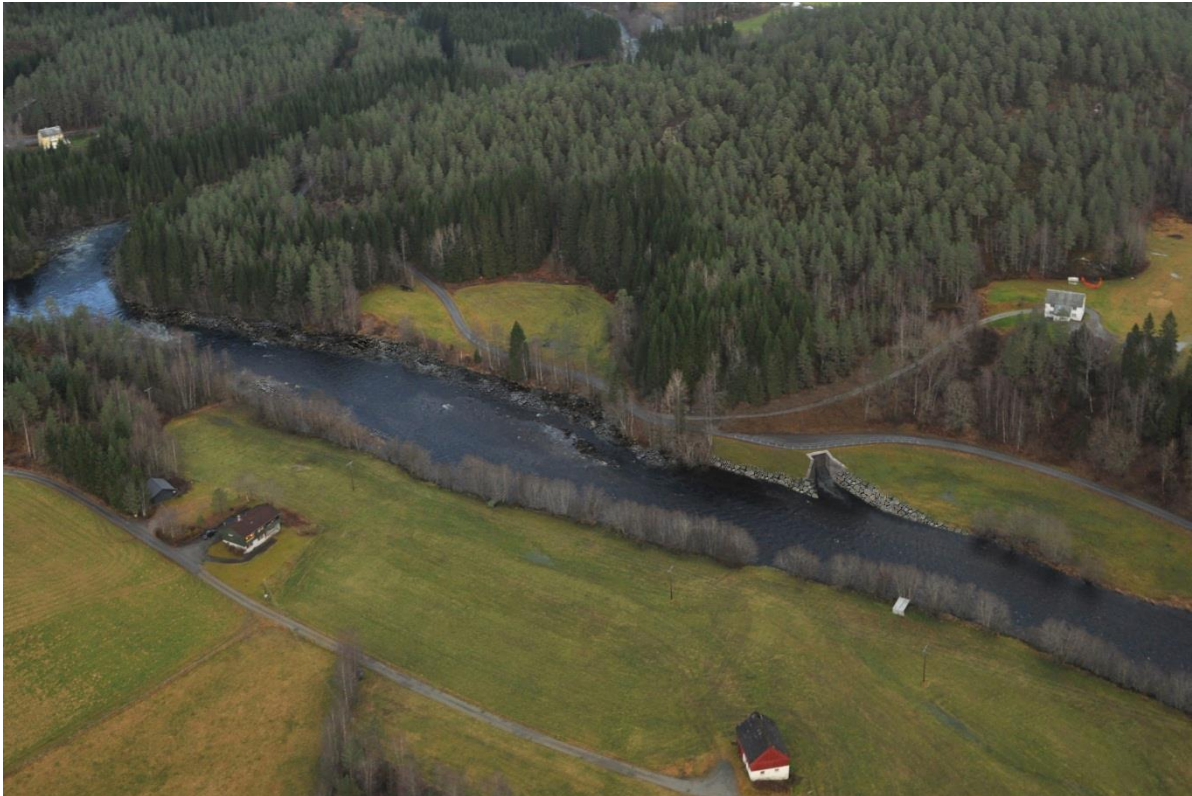
Figur 2-3. Avløpstunellen ender skrått vinklet nedstrøms. Her oppstår en kulp som strekker seg et stykke oppstrøms.
