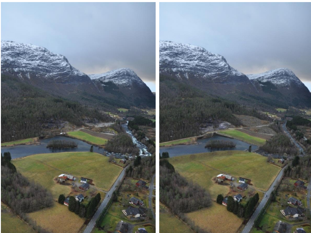
Figur 4. Inntaksområdet før (venstre) og etter (høyre) utbygging.
