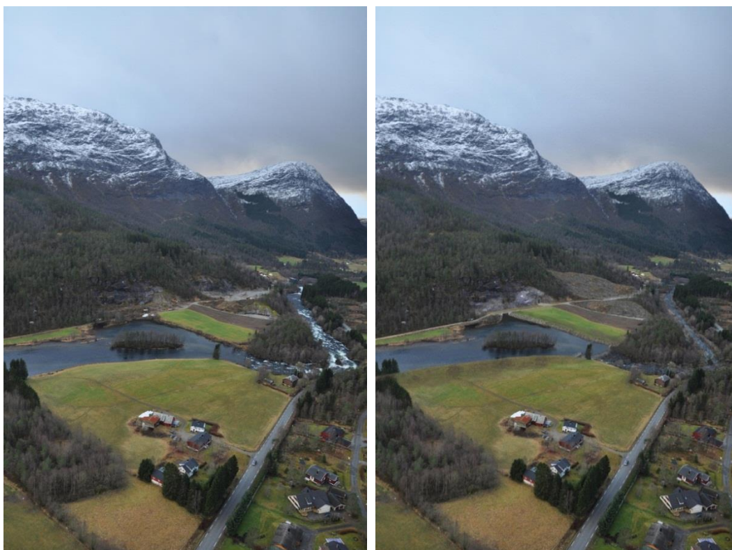
Figur 2. Inntaksområdet før (venstre) og etter (høyre) utbygging.
