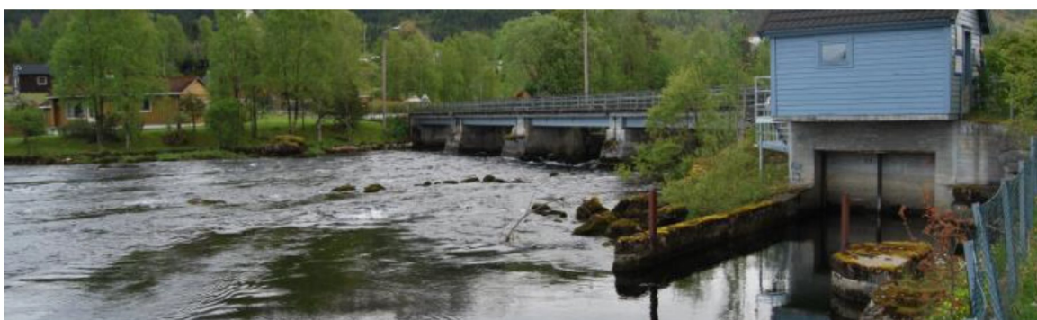
Figur 3. Damanlegg ved Jølstravatnet.
