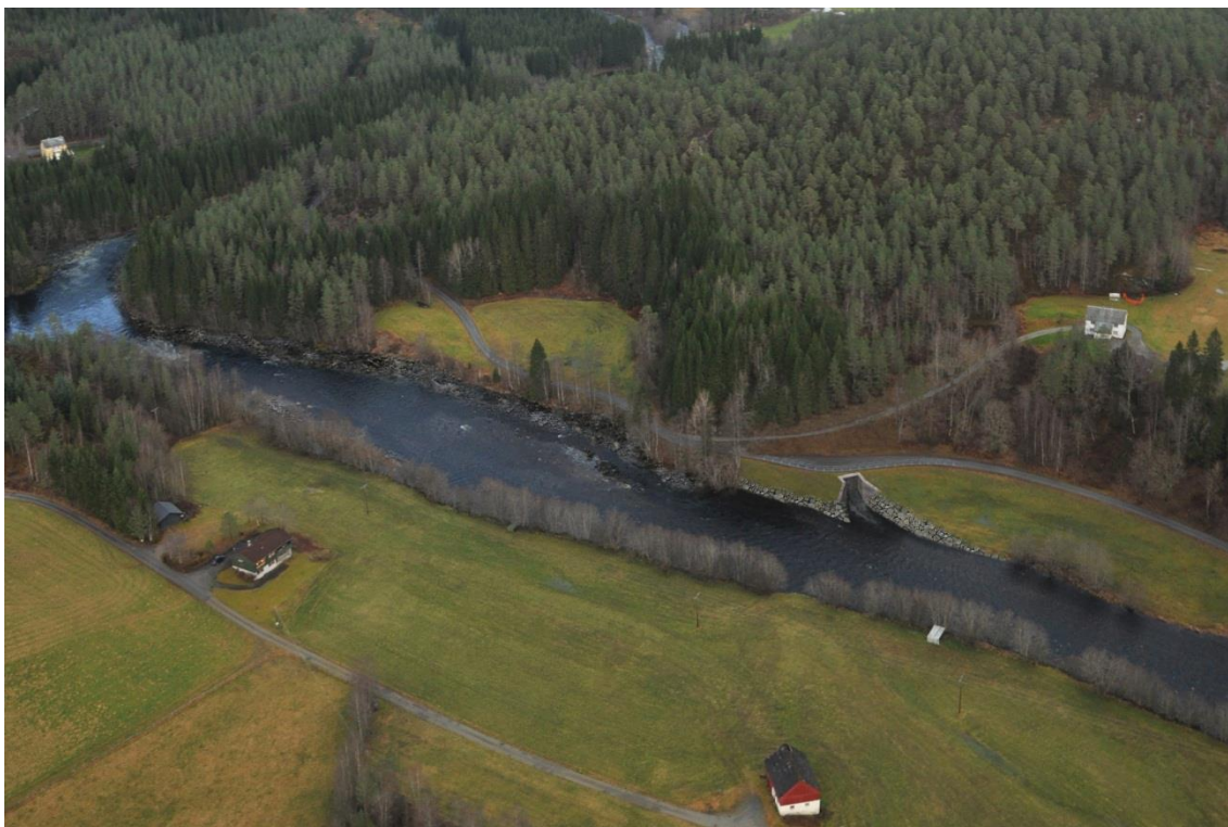
Figur 3. Avløpstunellen ender skrått vinklet nedstrøms. Her oppstår en kulp som strekker seg et stykke oppstrøms.
