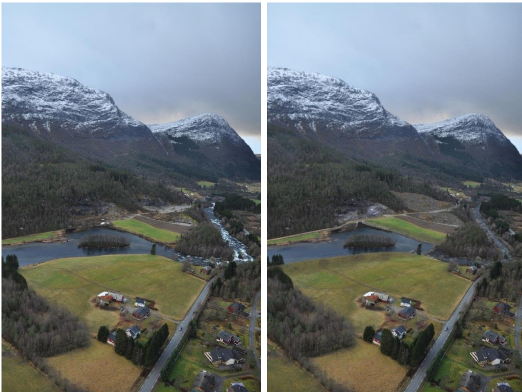
Figur 2. Inntaksområdet før (venstre) og etter (høyre) utbygging. Foto/illustrasjon: Multiconsult AS
