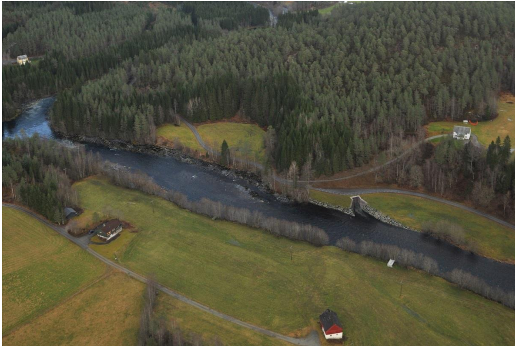
Figur 5. Avløpstunellen ender skrått vinklet nedstrøms. Her oppstår en kulp som strekker seg et stykke oppstrøms.
