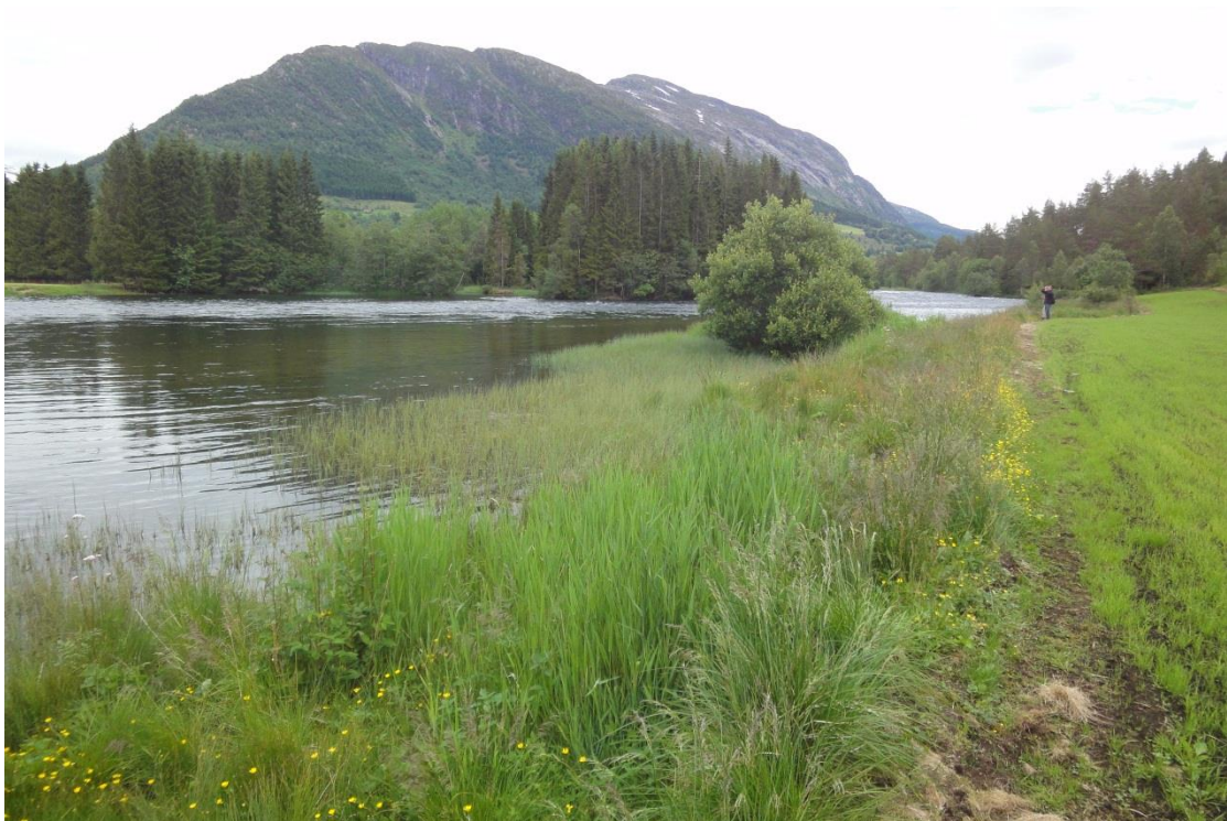
Figur 11. Flomutsatt område ved inntaket.
