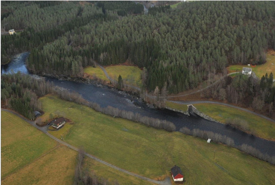
Figur 3. Avløpstunellen ender skrått vinklet nedstrøms. Her oppstår en kulp som strekker seg et stykke oppstrøms.
