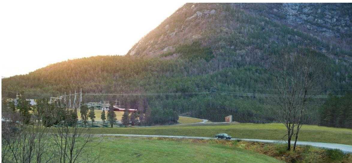
Figur 2-13 Området ved kraftstasjonen etter oppbygging. Illustrasjon Multiconsult og X-form.
