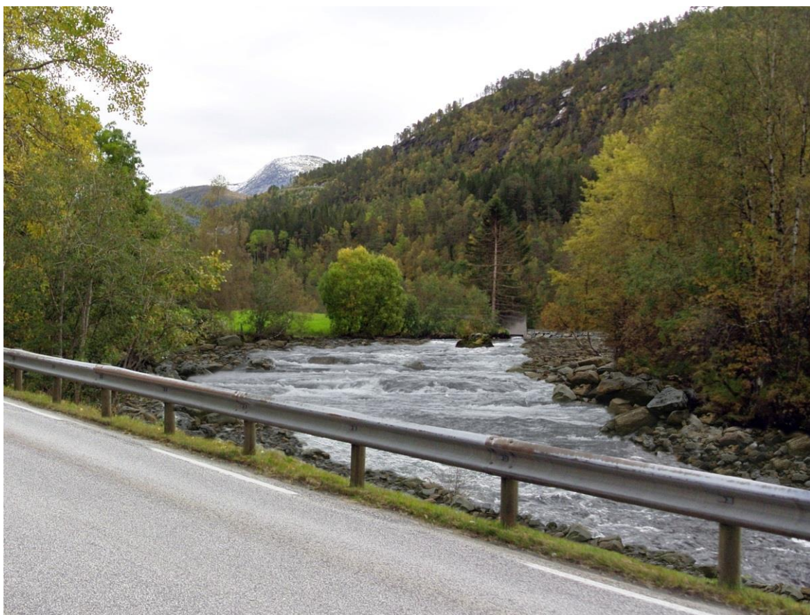
Figur 2-9: Inntaksområdet sett fra E 39, etter utbygging. Luke til slipp av minstevannføring og terskel skimtes sentralt/litt til høyre i bildet. Illustrasjon Multiconsult.
