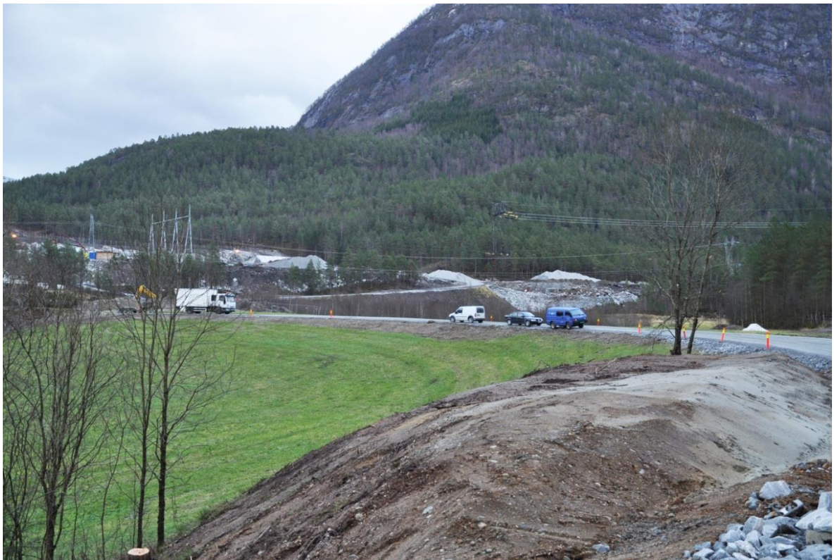
Figur 2-12 Området ved kraftstasjonen før oppbygging
