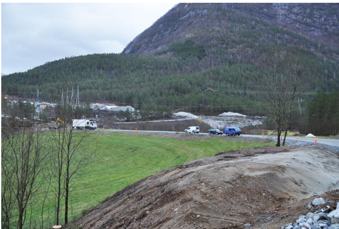
Figur 11-16. Kraftstasjonsområdet i Moskog. Området nær planlagt adkomst er allerede preget av byggingen av nytt koblingsanlegg for 420 kV-ledningen Ørskog – Fardal.
