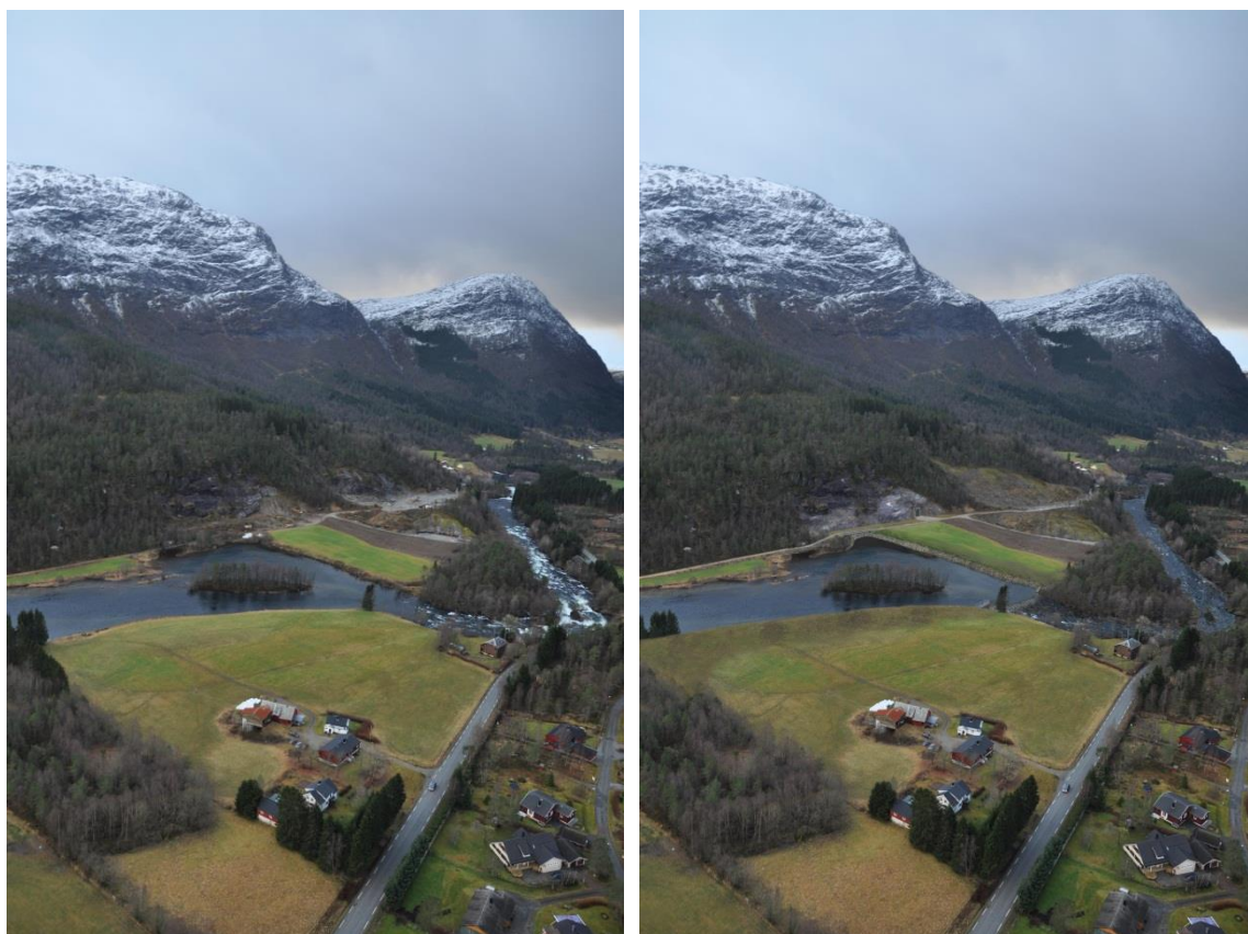
Figur 2-7: Inntaksområdet før (venstre) og etter (høyre) utbygging. I bildet til høyre har elva lavere vannføring. Rett ovenfor øya i Tongahølen er det en kanal inn til inntaket som er dykka og inn i fjellet. Over kanalen er det ei bru som er skjult med plastring slik at den ikke viser. Luke for slipp av minstevannføring og terskel kan skimtes til høyre for øya. En kan også se istandsatt massetak ovenfor og til høyre for brua. Illustrasjon Multiconsult.
