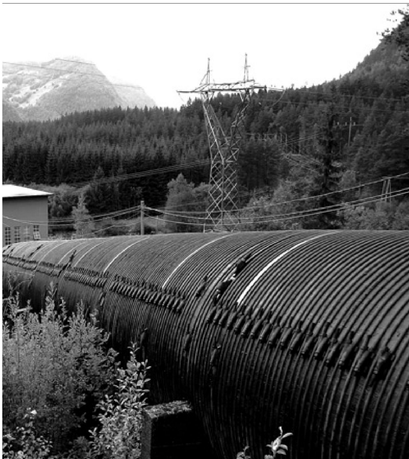
MÅ FORNYAST: Til grunn for utbyggingsplanane ligg også det faktum at den gamle kraftstasjonen i Stakaldefossen er over 50 år og treng fornying. Foto: Sigurd Løseth
