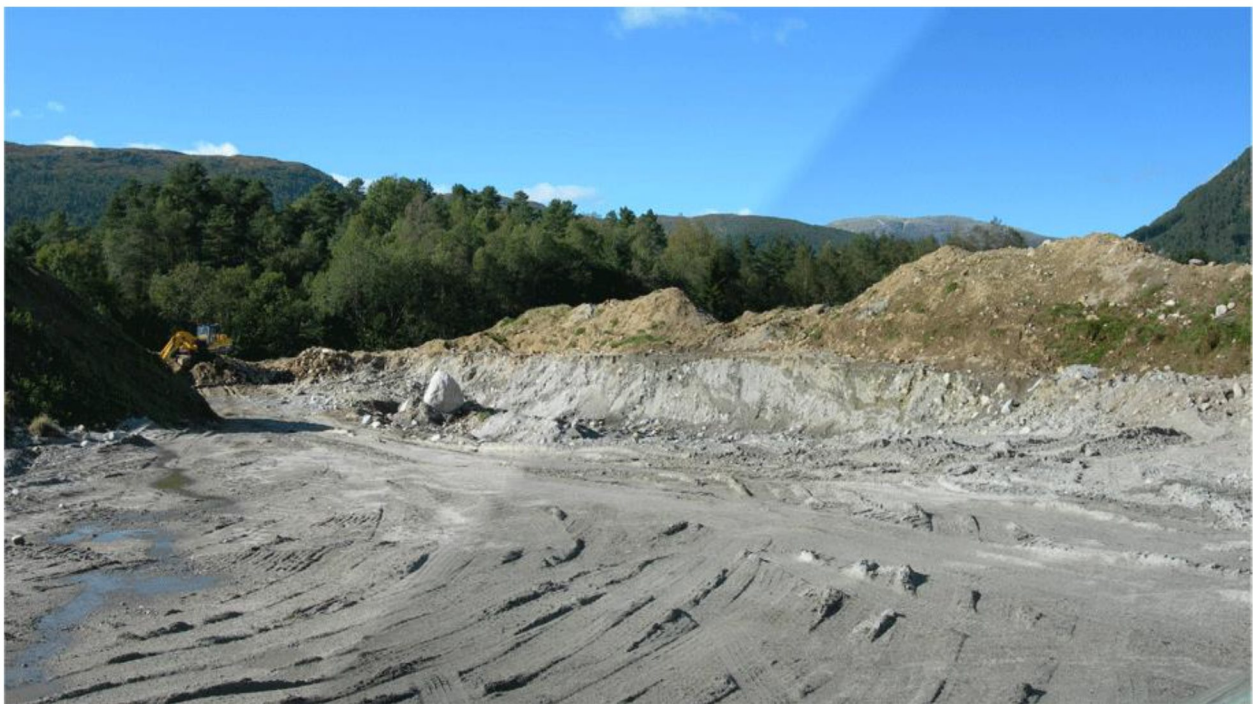
Fig.8: Planering av areal i grustaket ved Nesbakken, i austlege del, etter at grusen er tatt ut. Området er under planering i 2007.
