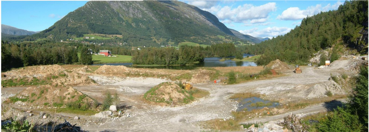
Fig.7: Starten på planering i området aust i forekomsten. Her skal det bli grasmark. Legg merke til vatn som ligg i pytter. Noko som tyder på at ein her er nær grunnvassspegelen. Datert i 2007.
