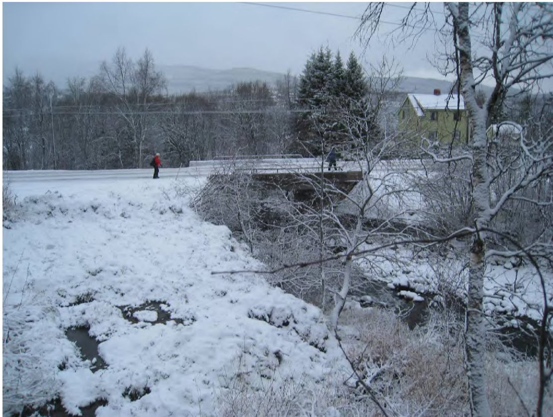
Kaldåga krysser E6 like nedenfor kraftstasjonen som knyttes til linja som sees på oversida av veggen
