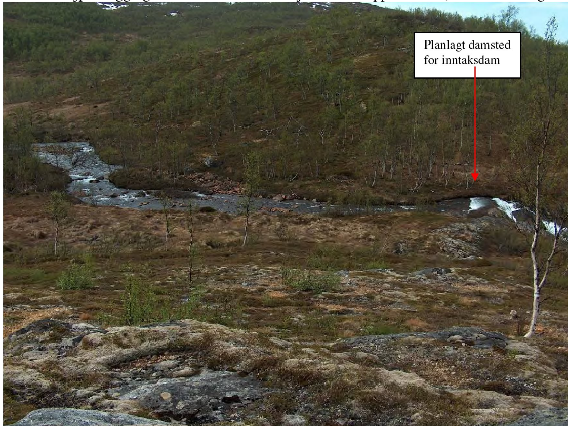
Parti av elva i inntaksområdet - inntaksdammen bygges på fossenakken til høyre
