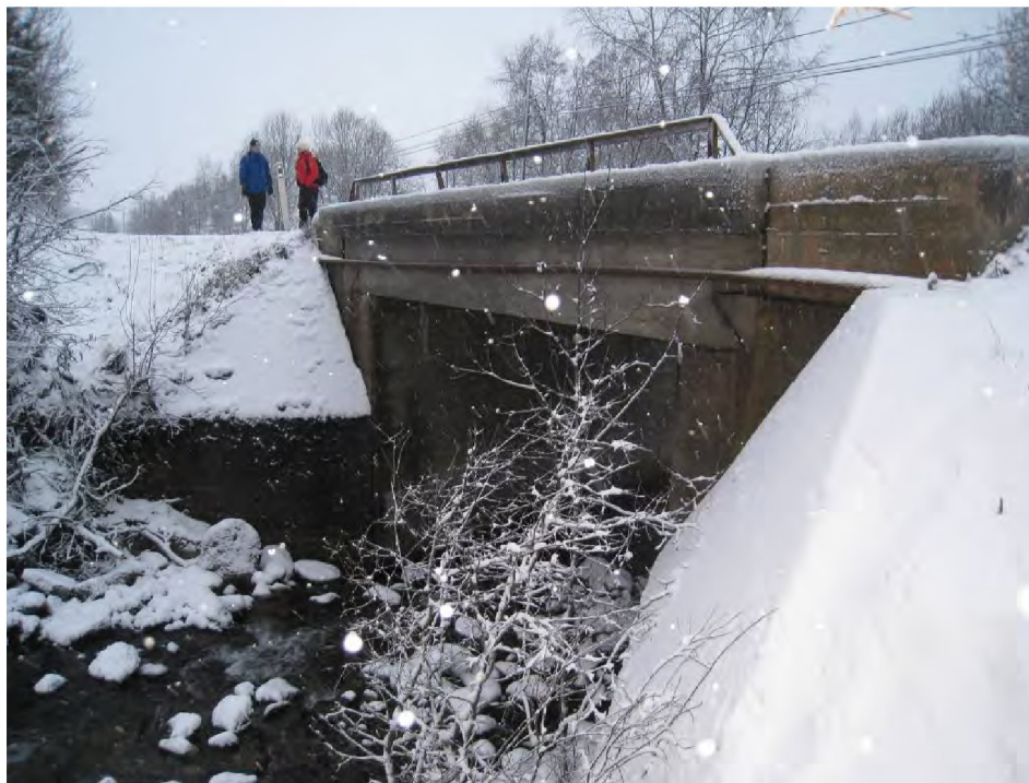
Kaldåga - bru over E6 nedenfor kraftstasjonen
