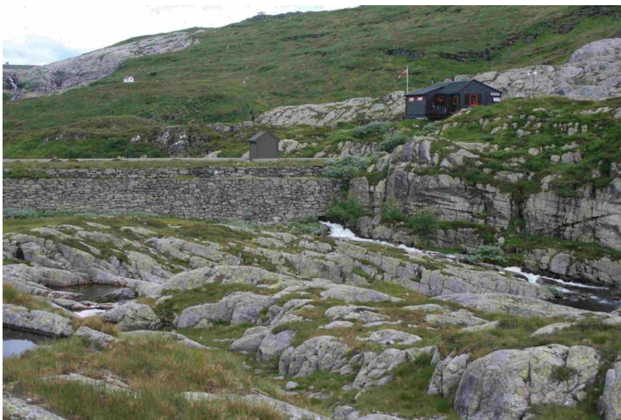
Figur 5. Her ser ein hovuddemninga i Fossavatnet og det var her ein regulerte vasstilgongen i elva og dei tekniske innretningane der inkl. Ardal kraftverk. Om den planlagde utbygginga vert gjennomført må mesteparten av vasstraumen strøypast ved dette utlaupet slik at hovudstraumen vert ført til Buhellervatnet litt lenger vest. Sjå figur 4! (Foto; Karl Johan Grimstad ©).
