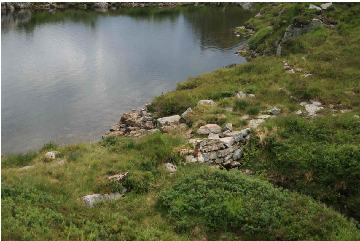
Figur 4. Her ser ein noverande overløp mot Buhellervatnet frå Fossavatnet. Ved ei eventuell utbygging må det gravast ned kanal eller røyr slik at Fossavatnet kan senkast og dermed kunne utnytta reguleringa av vatnet. (Foto; Karl Johan Grimstad ©).
