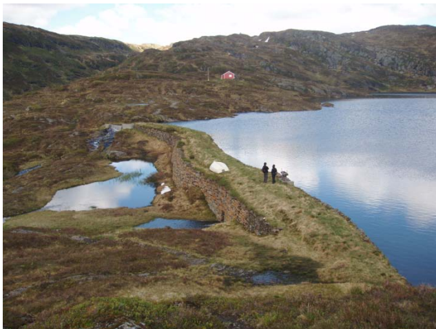
Dam Buhellervatn. Inntak til Herfindal kraftverk er planlagt ved næraste landtak.
