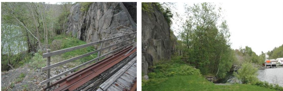
Figur 7 t.v. viser veien fra jernbanelinjen og ned mot kraftstasjonsområdet. Figur 8 t.h. viser området for kraftstasjonen sett nedenfra samt eksisterende atkomstvei under heia til venstre i bildet. Jfr. fig. 6.
