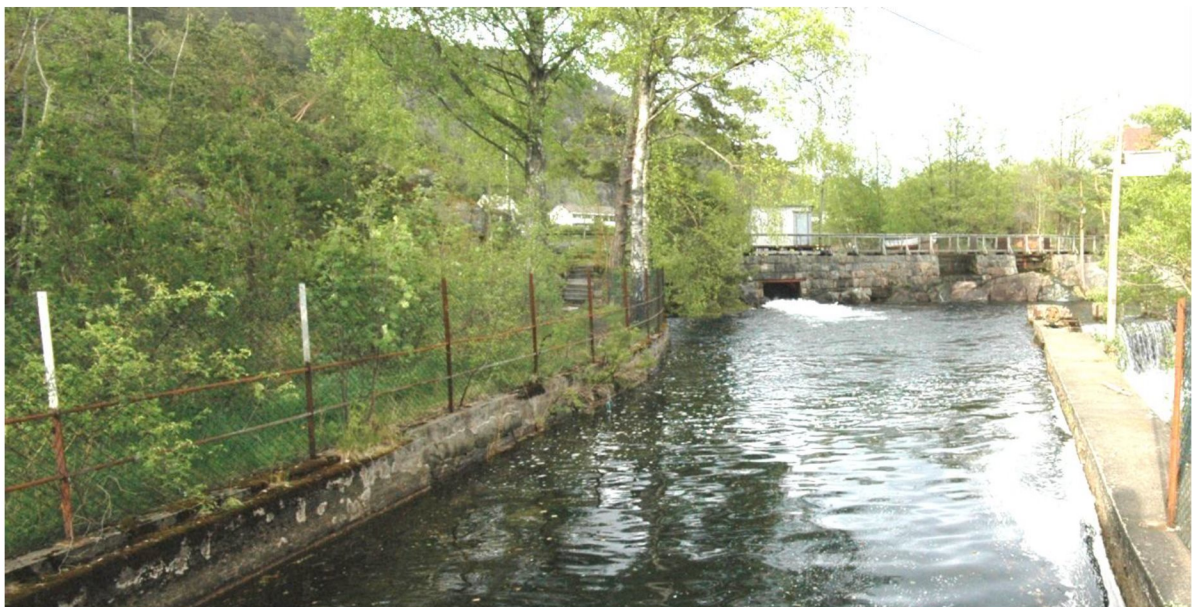
Figur 19 Viser dam sett nedenfra. Inntaket planlegges i kanten av damanlegget t.v.i bildet. Jamfør figur 6.
