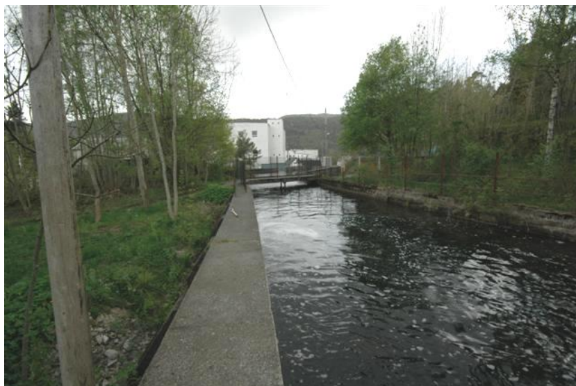
Figur 5 viser fortsettelsen av inntaksdam i figur 4 som strekker seg ned mot det gamle kraftverket for øvre del av Selurelva.
