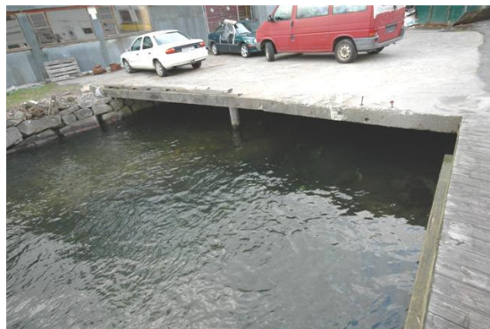
Elveos og kulvert retning gml. Kraftverk
