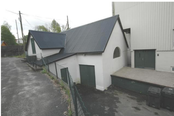
Nedlagt kraftstasjon ved inntaksdam
