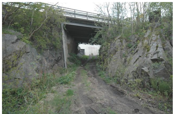
Kulvert under fylkesvei
