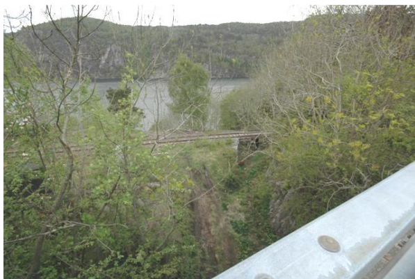
Fra fylkesvei (over kulvert) mot stasjonsområde
