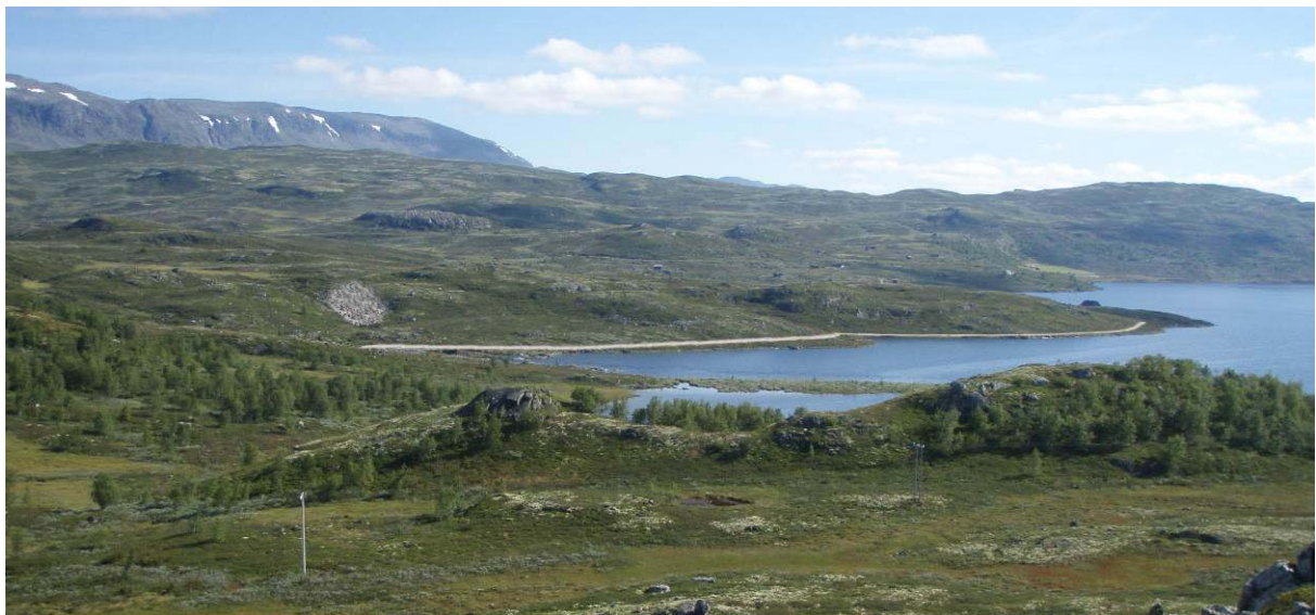
Figur 4-12 Visualisering av massedeponi og veg. Øverste foto viser dagens situasjon. Under vises anleggsvegen som vil bli liggende i overkant av reguleringssonen og massedeponiet som blir liggende i en skråning ovenfor vannet. Visualisering: Sweco.
