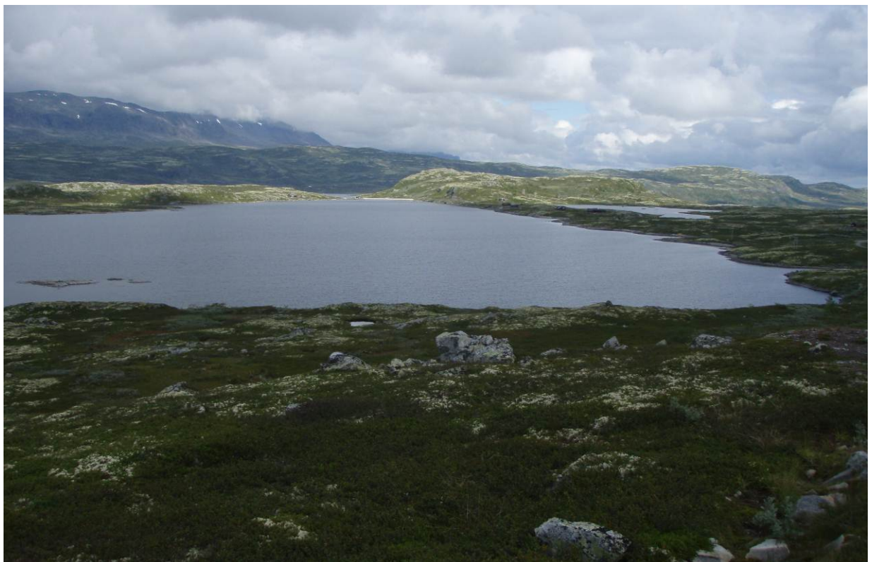
Figur 4-10 Østenden av Mjåvatn med tilnærmet fullt magasin. Dammen ses i midten av bildet.
