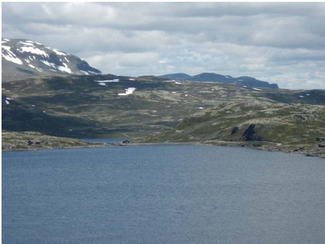
Mot Mjøvatn dam og inntaksområde Mjøvatn kraftverk
