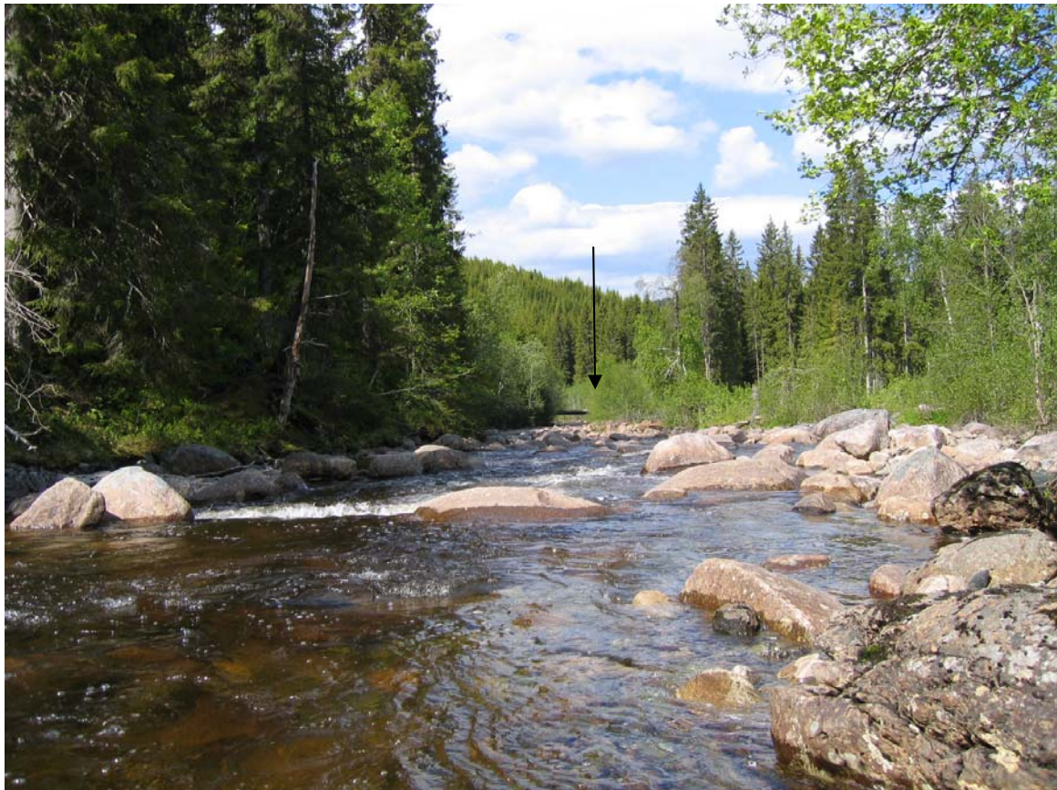
Like nedstrøms kraftstasjonsplassering og bru over Brunga anvist med pil
