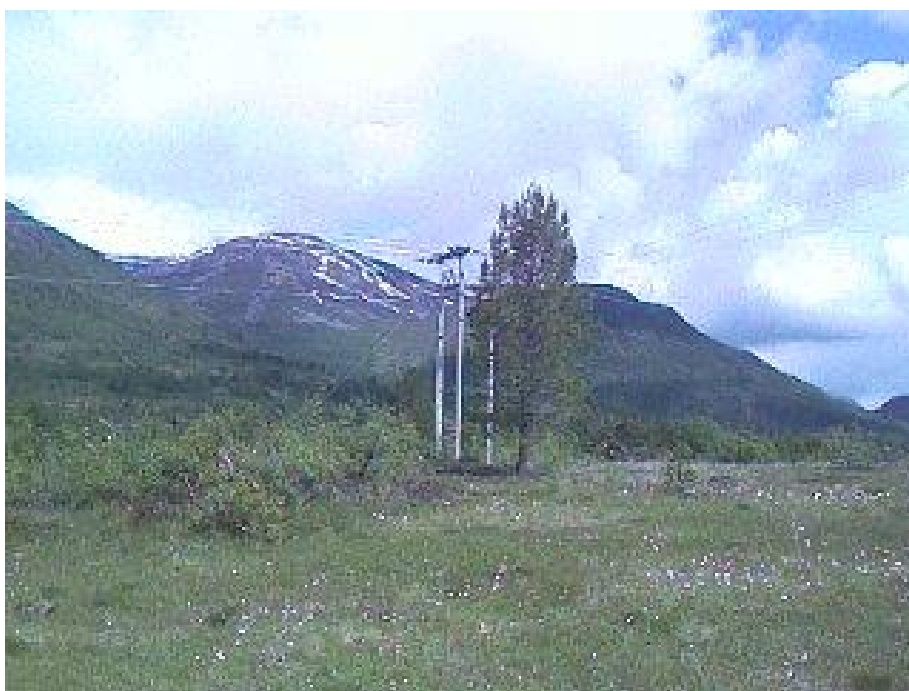
Jordkabel mellom stasjon og planlagt påkoblingspunkt (bildet)
