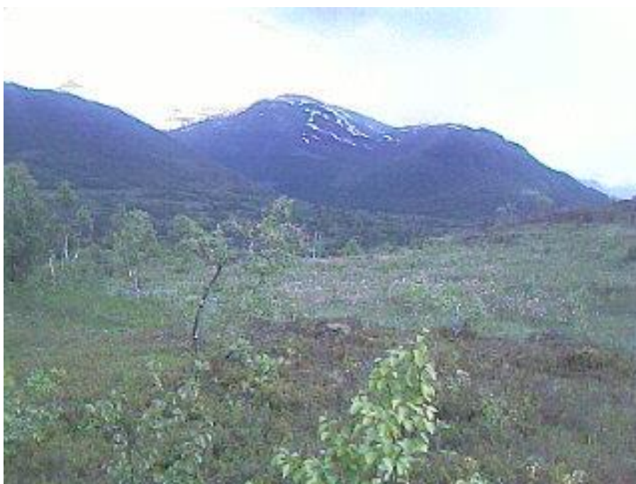
Nedre del av rørgatetrase. Stolpe for tilknytning til 22 kV linje ses lengst vekk i bildet.
