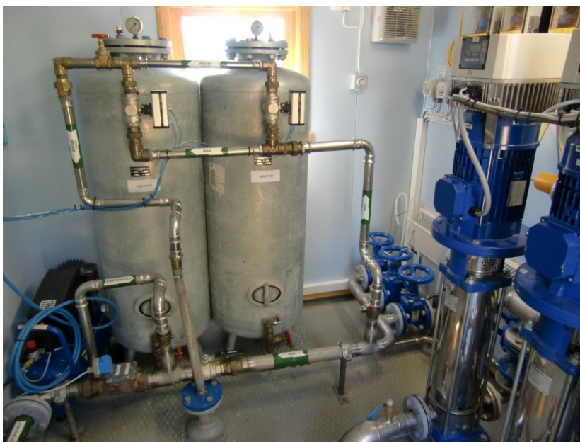
Figur 7: Vannbehandlingsanlegg med marmorfilter til venstre og pumper til høyre.
