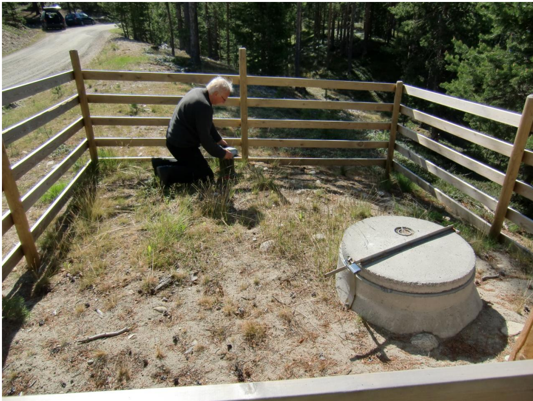
Figur 8: Borebrønn B1A i betongkum til høyre, peilebrønn til venstre ved personen i bildet.
