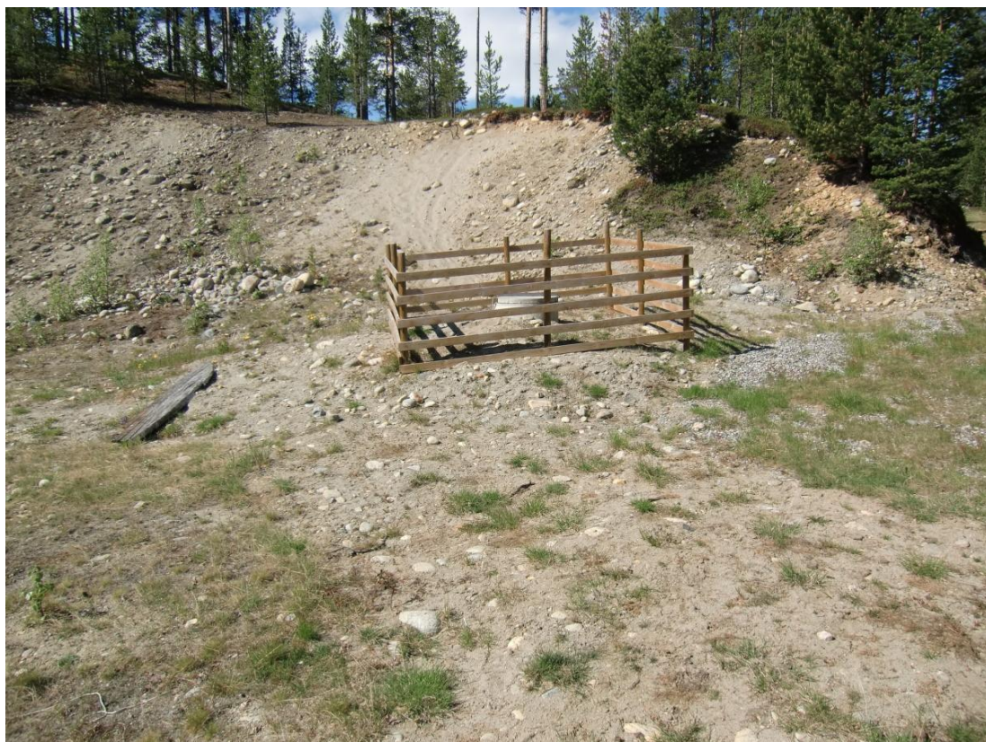
Figur 9: Gravd brønn i nedlagt grustak, inngjerdet og beskyttet med betongkum m/ låsbart lokk.
