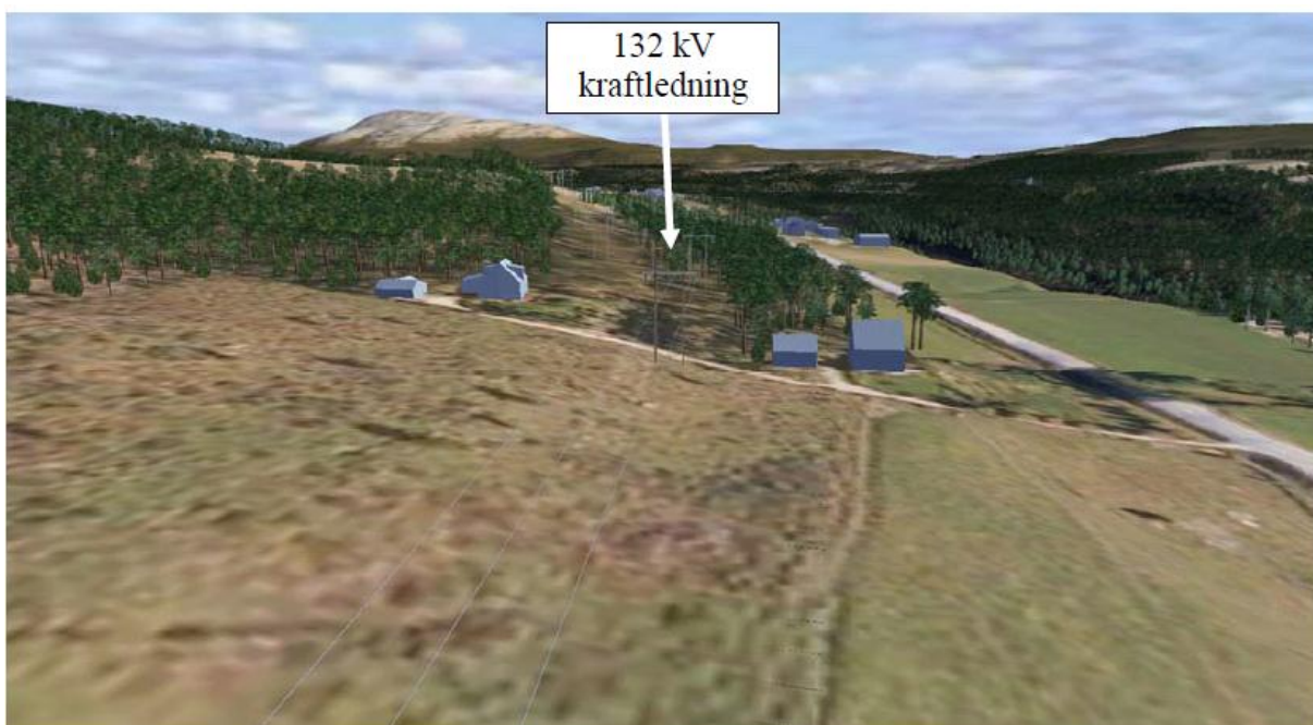
Figur 11: Nettalternativ 1.2. Eksisterende 22 kV-nett kables (inkludert avgreininger nord og sør for Storbekken), mens ny 132 kV-kraftledning bygges som luftledning i den gamle traséen.
