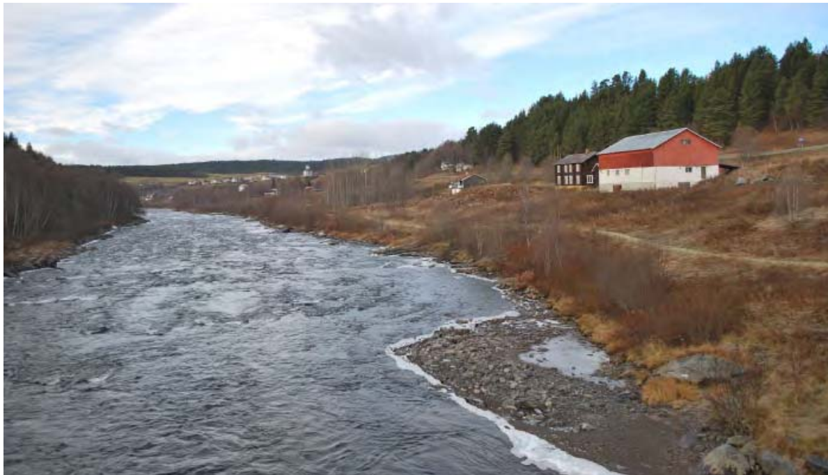
Bilde 7. Reelt bilde nedstrøms Gammelbrua ved vannføring 12 \text{ m}^3/\text{s} .
